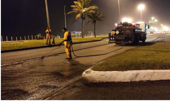
SERVIÇO: PINTURA DE LIGAÇÃO
