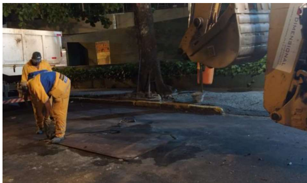
SERVIÇO: LEVANTAMENTO DE TAMPÕES
