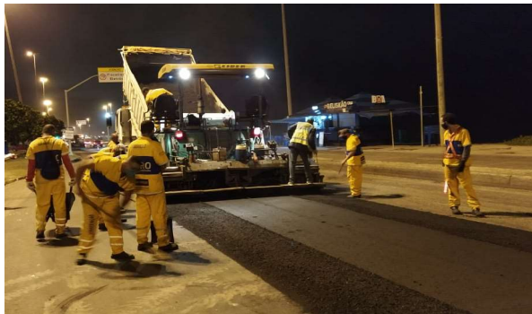
SERVIÇO: ESPALHAMENTO DE ASFALTO
