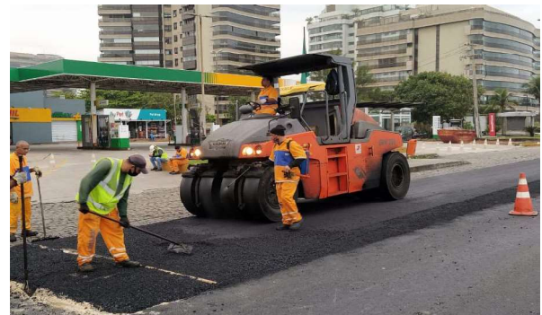
SERVIÇO: COMPACTAÇÃO MECÂNICA
