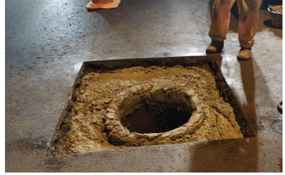
SERVIÇO: LEVANTAMENTO DE TAMPÕES
