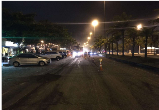
SERVIÇO: SINALIZAÇÃO DE OBRAS
