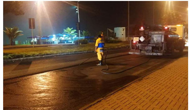
SERVIÇO: PINTURA DE LIGAÇÃO
