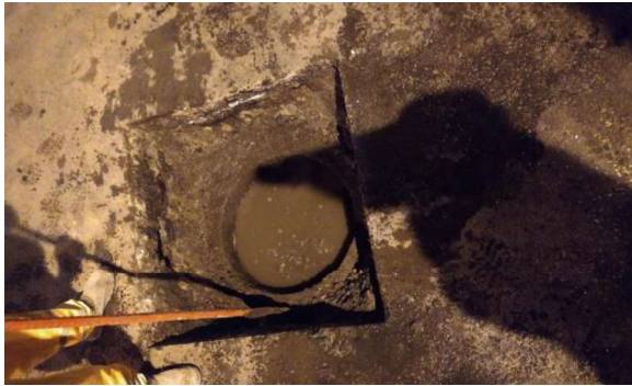
SERVIÇO: LEVANTAMENTO DE TAMPÕES
