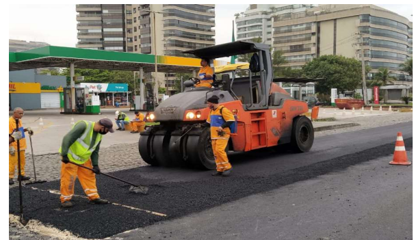
SERVIÇO: COMPACTAÇÃO MECÂNICA
