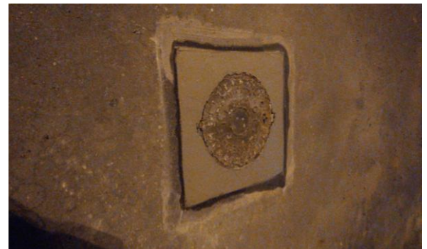
SERVIÇO: LEVANTAMENTO DE TAMPÕES
