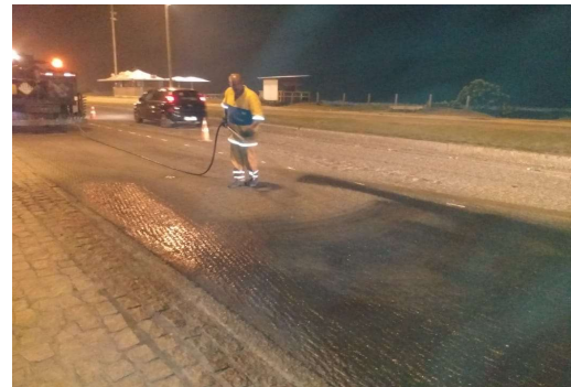
SERVIÇO: PINTURA DE LIGAÇÃO
