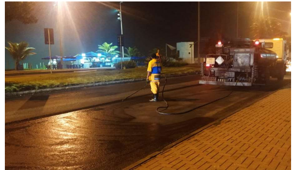
SERVIÇO: PINTURA DE LIGAÇÃO
