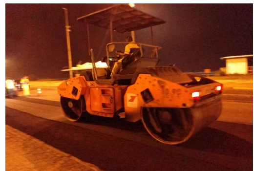
SERVIÇO: COMPACTAÇÃO MECÂNICA
