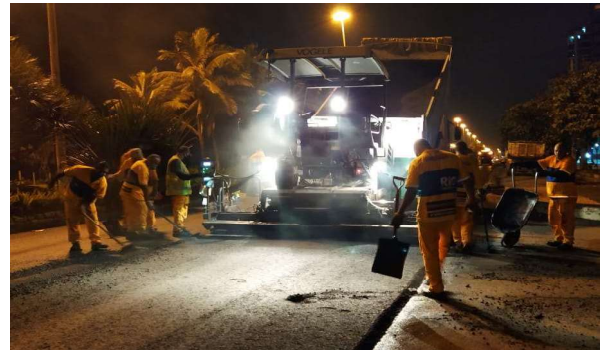
SERVIÇO: ESPALHAMENTO DE ASFALTO
