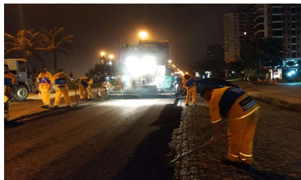
SERVIÇO: ESPALHAMENTO DE ASFALTO
