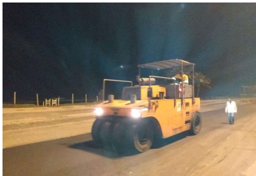
SERVIÇO: COMPACTAÇÃO MECÂNICA
