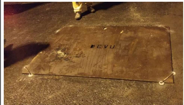
SERVIÇO: LEVANTAMENTO DE TAMPÕES
