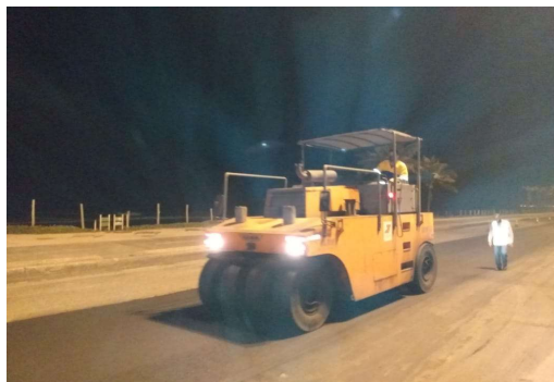
SERVIÇO: COMPACTAÇÃO MECÂNICA
