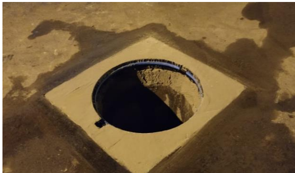
SERVIÇO: LEVANTAMENTO DE TAMPÕES
