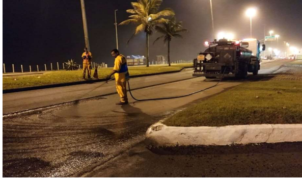
SERVIÇO: PINTURA DE LIGAÇÃO
