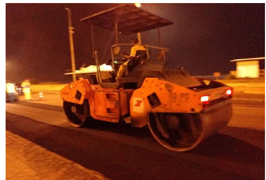
SERVIÇO: COMPACTAÇÃO MECÂNICA
