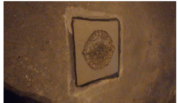
SERVIÇO: LEVANTAMENTO DE TAMPÕES
