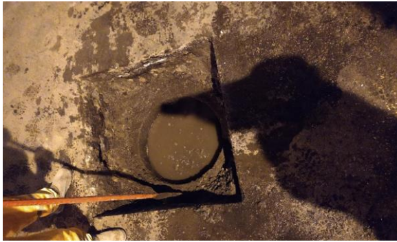
SERVIÇO: LEVANTAMENTO DE TAMPÕES
