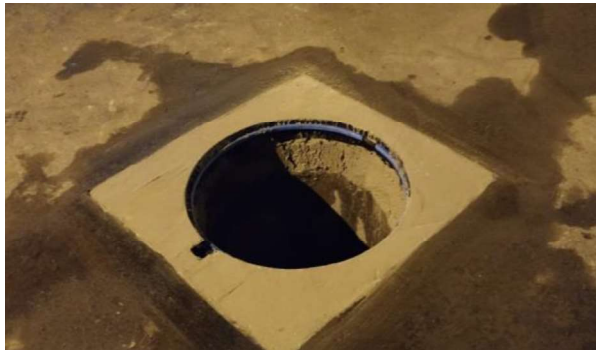
SERVIÇO: LEVANTAMENTO DE TAMPÕES
