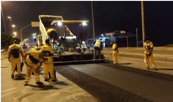
SERVIÇO: ESPALHAMENTO DE ASFALTO
