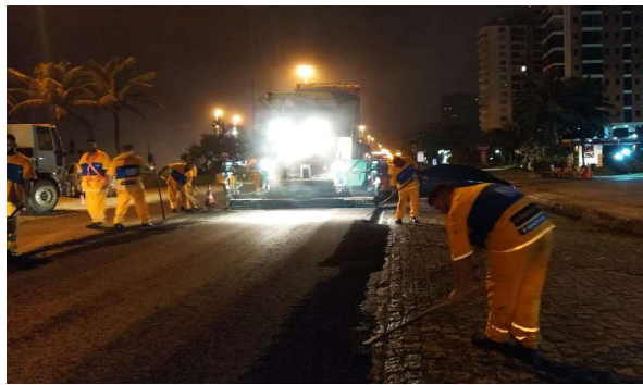
SERVIÇO: ESPALHAMENTO DE ASFALTO
