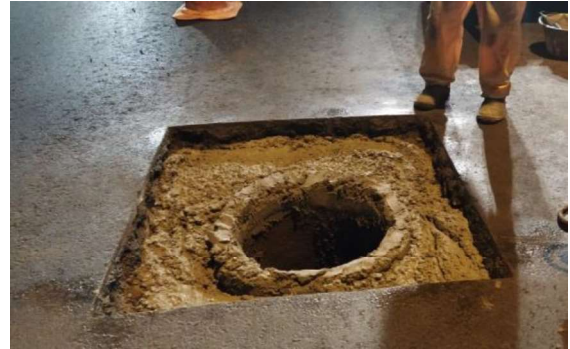
SERVIÇO: LEVANTAMENTO DE TAMPÕES
