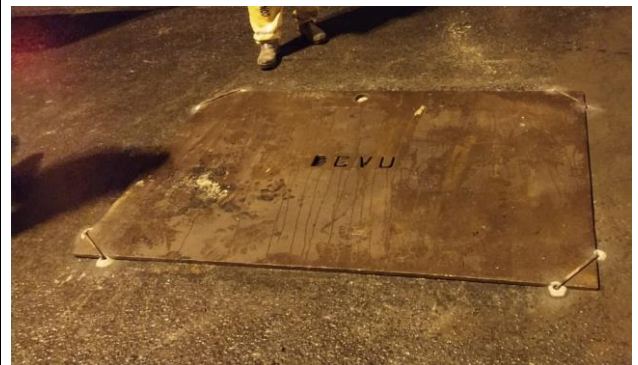
SERVIÇO: LEVANTAMENTO DE TAMPÕES
