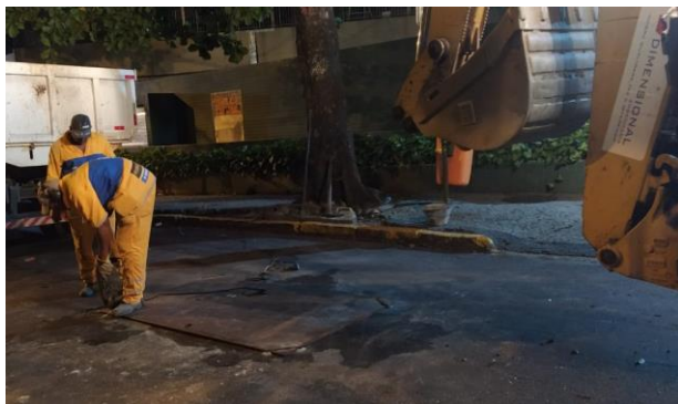
SERVIÇO: LEVANTAMENTO DE TAMPÕES
