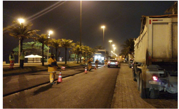
SERVIÇO: SINALIZAÇÃO DE OBRAS
