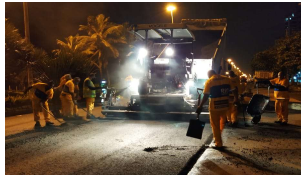
SERVIÇO: ESPALHAMENTO DE ASFALTO
