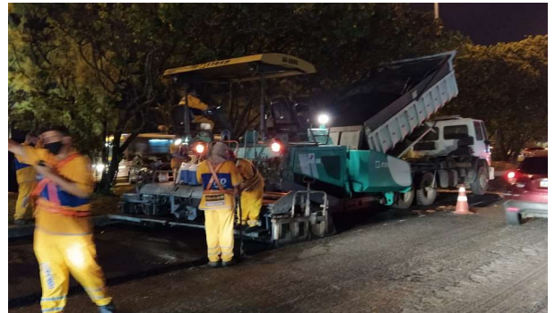
SERVIÇO: ESPALHAMENTO DE ASFALTO
