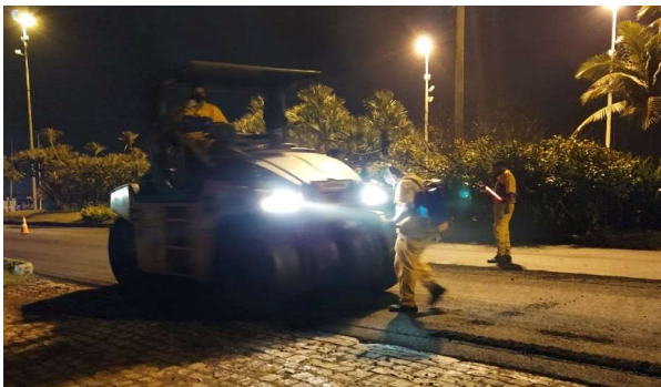
SERVIÇO: COMPACTAÇÃO MECÂNICA (2ª CAMADA)
