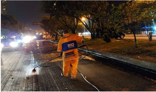
SERVIÇO: PINTURA DE LIGAÇÃO
