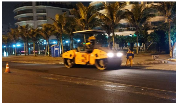
SERVIÇO: COMPACTAÇÃO MECÂNICA (2ª CAMADA)
