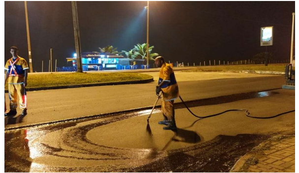
SERVIÇO: PINTURA DE LIGAÇÃO (2ª CAMADA)
