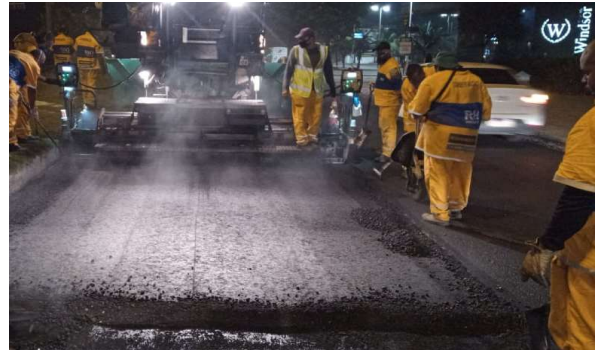
SERVIÇO: ESPALHAMENTO DE ASFALTO
