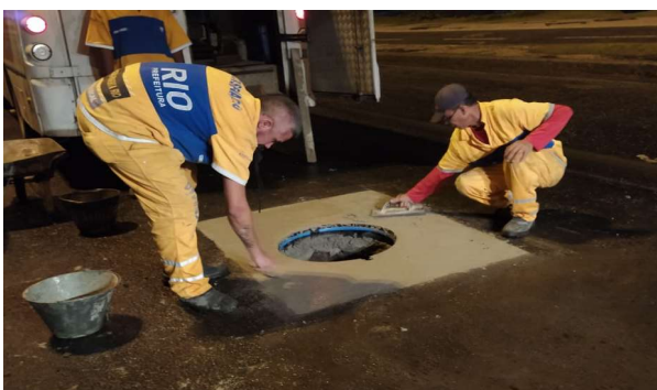
SERVIÇO: LEVANTAMENTO DE TAMPÃO
