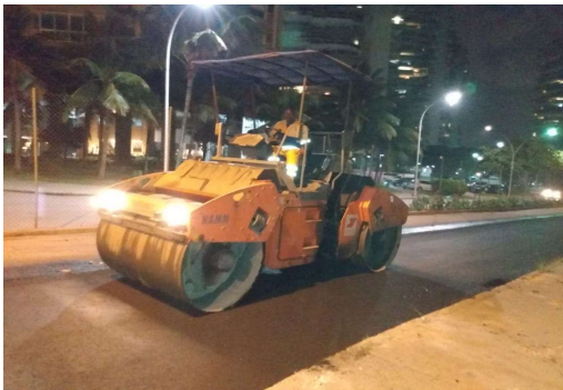
SERVIÇO: COMPACTAÇÃO MECÂNICA
