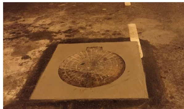
SERVIÇO: LEVANTAMENTO DE TAMPÃO
