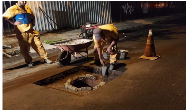
SERVIÇO: LEVANTAMENTO DE TAMPÃO
