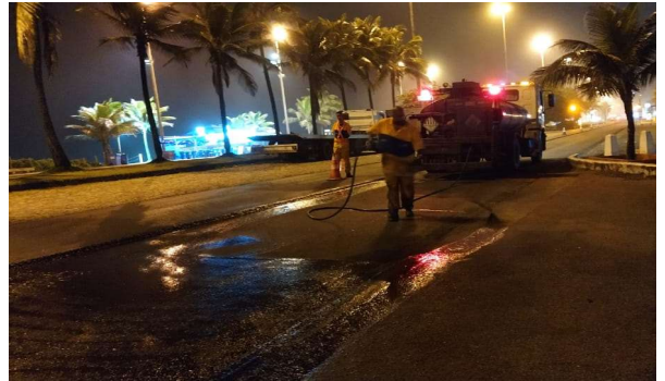
SERVIÇO: PINTURA DE LIGAÇÃO (2ª CAMADA)
