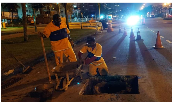
SERVIÇO: LEVANTAMENTO DE TAMPÃO
