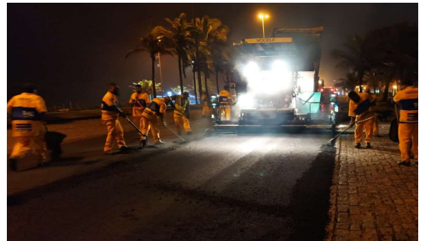
SERVIÇO: APLICAÇÃO DE GEOGRELHA
