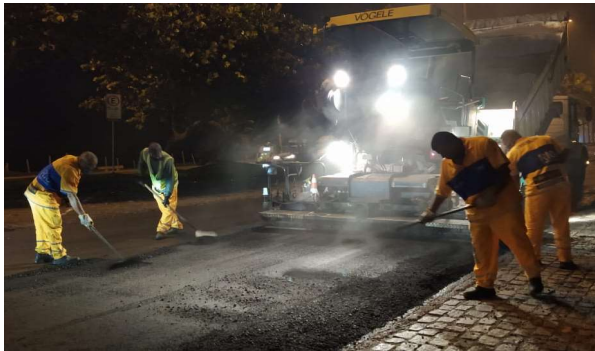
SERVIÇO: ESPALHAMENTO DE CBUQ (2ª CAMADA)
