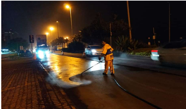
SERVIÇO: PINTURA DE LIGAÇÃO (2ª CAMADA)
