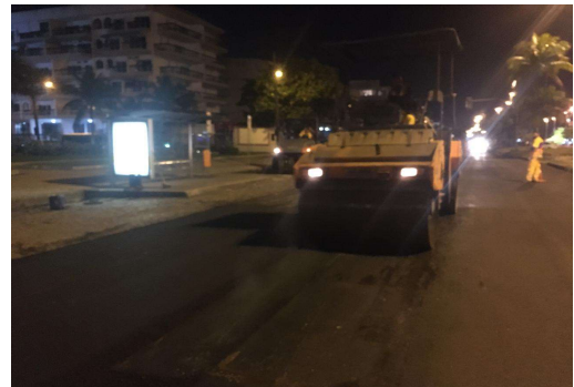
SERVIÇO: COMPACTAÇÃO MECÂNICA
