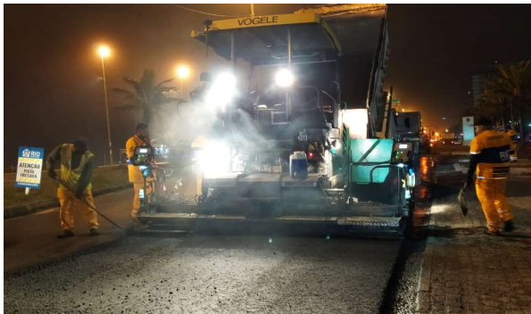
SERVIÇO: ESPALHAMENTO DE CBUQ (2ª CAMADA)
