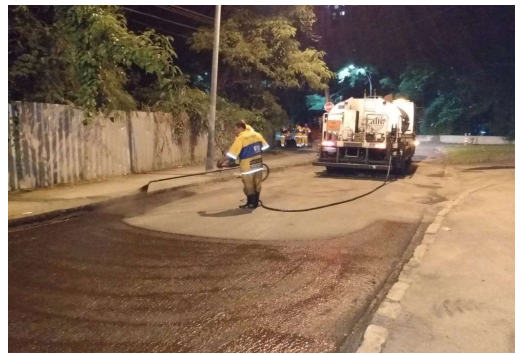
SERVIÇO: PINTURA DE LIGAÇÃO
