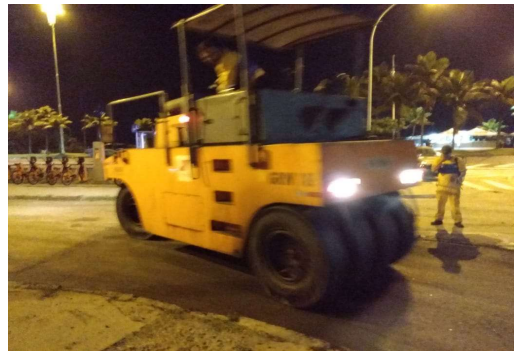
SERVIÇO: COMPACTAÇÃO MECÂNICA
