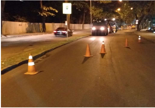
SERVIÇO: SINALIZAÇÃO DE OBRAS
