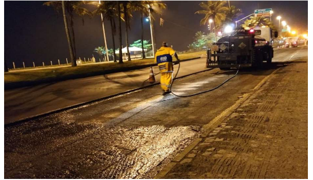
SERVIÇO: PINTURA DE LIGAÇÃO
