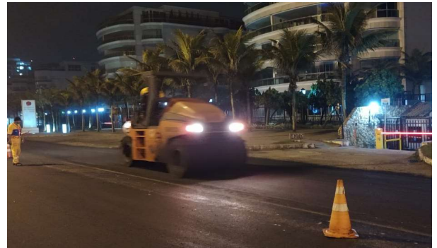
SERVIÇO: COMPACTAÇÃO MECÂNICA (2ª CAMADA)
