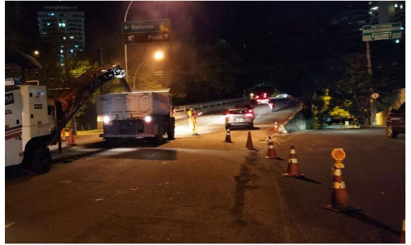
SERVIÇO: SINALIZAÇÃO DE OBRAS
