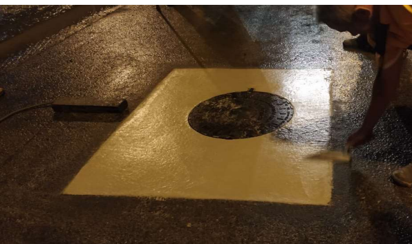
SERVIÇO: LEVANTAMENTO DE TAMPÃO
