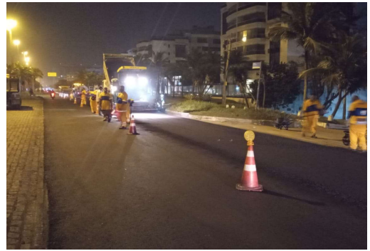
SERVIÇO: SINALIZAÇÃO DE OBRAS
