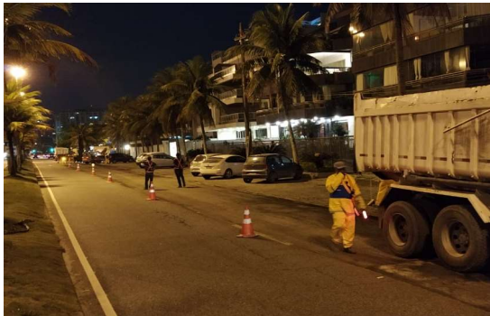
SERVIÇO: SINALIZAÇÃO DE OBRAS
