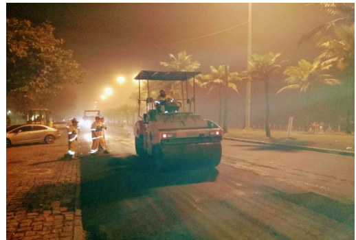
SERVIÇO: COMPACTAÇÃO (2ª CAMADA)
