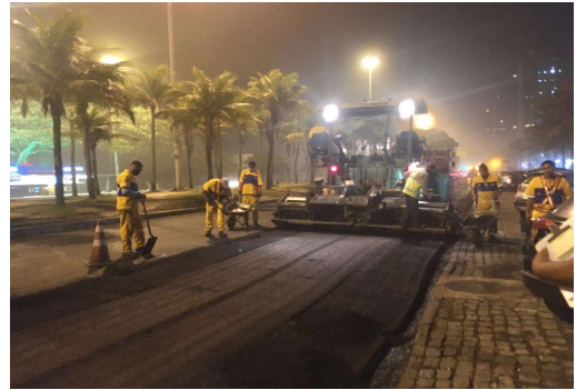
SERVIÇO: ESPALHAMENTO DE CBUQ (2ª CAMADA)
