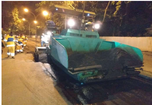
SERVIÇO: ESPALHAMENTO DE ASFALTO
