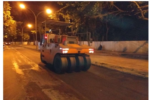
SERVIÇO: PINTURA DE LIGAÇÃO (2ª CAMADA)
