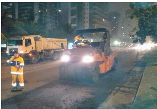
SERVIÇO: COMPACTAÇÃO (2ª CAMADA)
