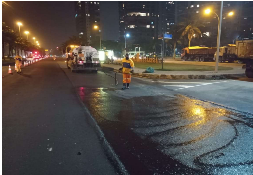
SERVIÇO: PINTURA DE LIGAÇÃO (2ª CAMADA)
