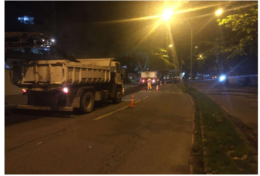
SERVIÇO: SINALIZAÇÃO DE OBRAS
