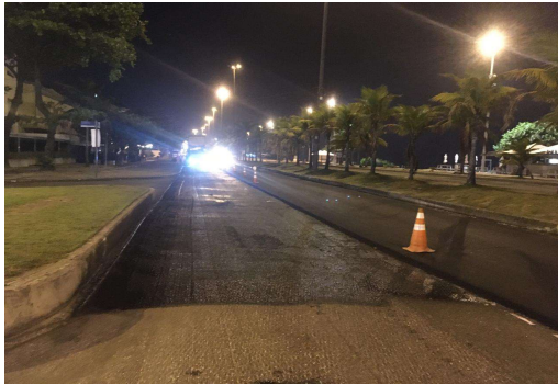
SERVIÇO: PINTURA DE LIGAÇÃO
