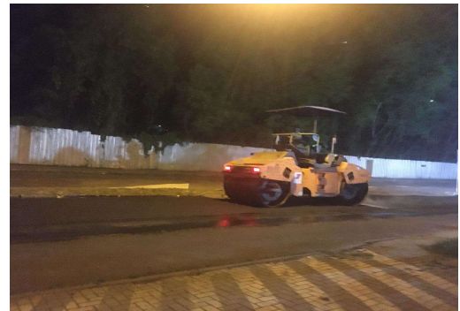
SERVIÇO: ESPALHAMENTO DE ASFALTO
