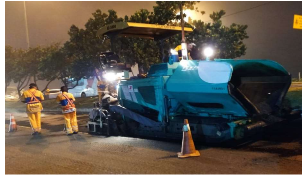
SERVIÇO: ESPALHAMENTO DE ASFALTO
