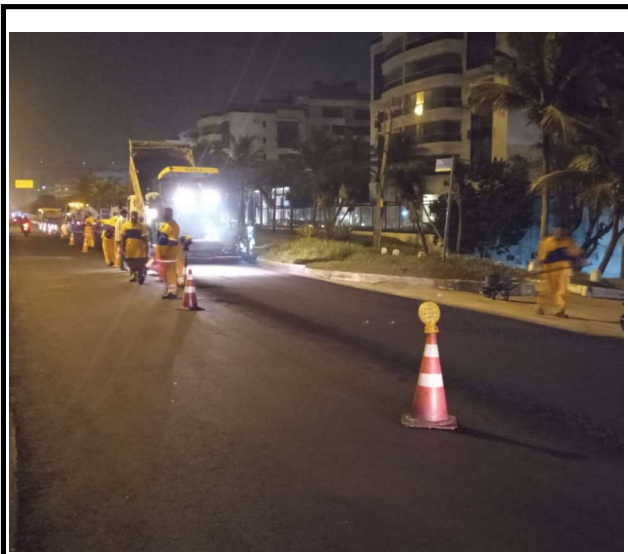
AV. LUCIO COSTA SINALIZAÇÃO DE OBRA
