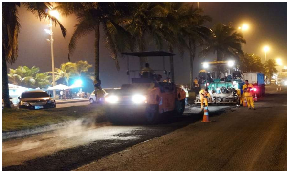
SERVIÇO: COMPACTAÇÃO MECÂNICA
