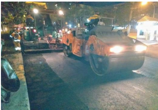
SERVIÇO: COMPACTAÇÃO (2ª CAMADA)
