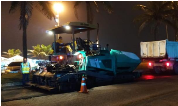
SERVIÇO: ESPALHAMENTO DE CBUQ (2ª CAMADA)
