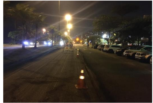
SERVIÇO: SINALIZAÇÃO DE OBRAS
