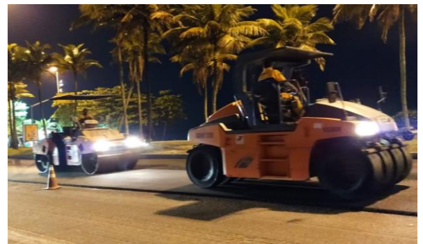
SERVIÇO: COMPACTAÇÃO MECÂNICA
