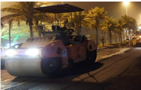
SERVIÇO: COMPACTAÇÃO (2ª CAMADA)
