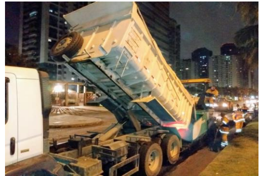
SERVIÇO: ESPALHAMENTO DE ASFALTO
