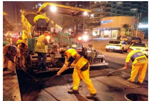
SERVIÇO: ESPALHAMENTO DE CBUQ (2ª CAMADA)
