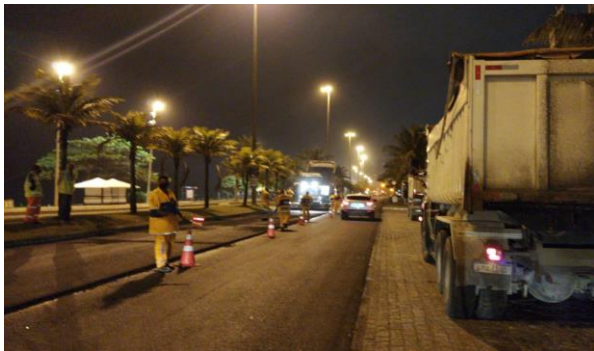
SERVIÇO: SINALIZAÇÃO DE OBRAS
