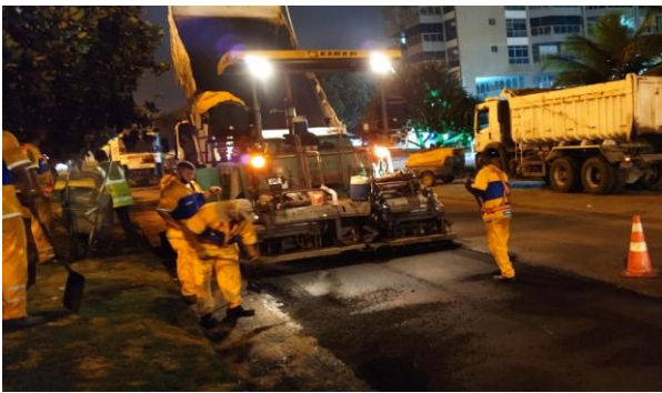
SERVIÇO: ESPALHAMENTO DE ASFALTO
