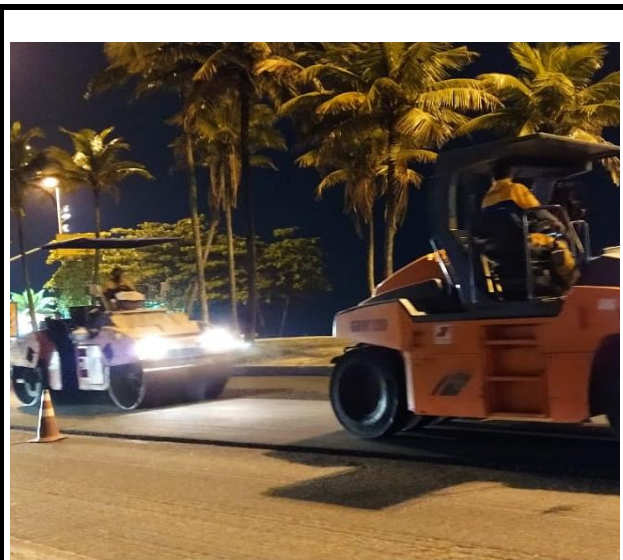
AV. LUCIO COSTA COMPACTAÇÃO (1ª CAMADA)
