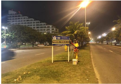
SERVIÇO: SINALIZAÇÃO DE OBRAS
