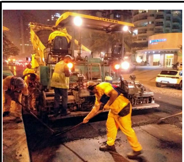
AV. LUCIO COSTA ESPALHAMENTO DE ASFALTO (2ª CAMADA)
