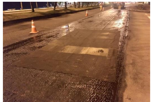
SERVIÇO: APLICAÇÃO DE GEOGRELHA
