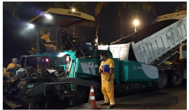
SERVIÇO: ESPALHAMENTO DE ASFALTO
