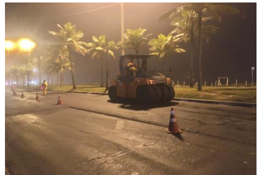
SERVIÇO: COMPACTAÇÃO (2ª CAMADA)
