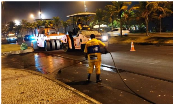
SERVIÇO: PINTURA DE LIGAÇÃO (2ª CAMADA)
