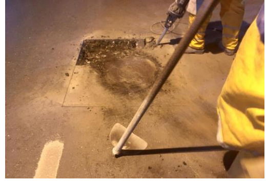
SERVIÇO: LEVANTAMENTO DE TAMPÃO
