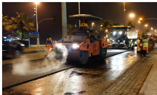
SERVIÇO: COMPACTAÇÃO (2ª CAMADA)
