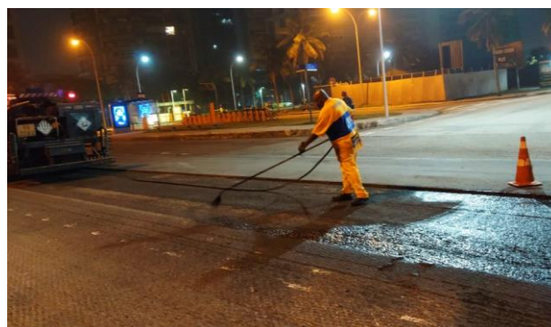
SERVIÇO: REPERFILAGEM DE PAVIMENTO
