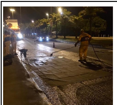
AV. LUCIO COSTA APLICAÇÃO DE GEOTRELA
