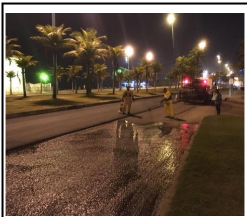
AV. LUCIO COSTA PINTURA DE LIGAÇÃO (1ª CAMADA)
