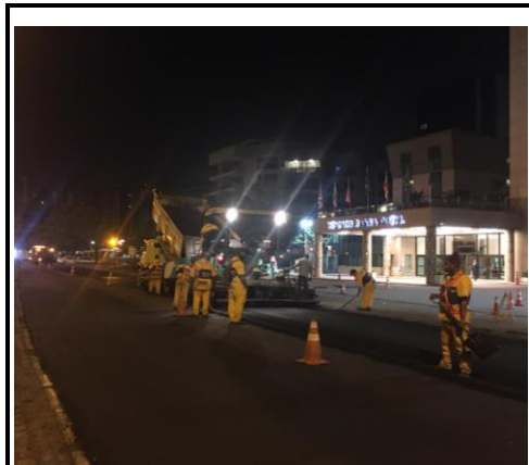
AV. LUCIO COSTA ESPALHAMENTO DE ASFALTO (1ª CAMADA)
