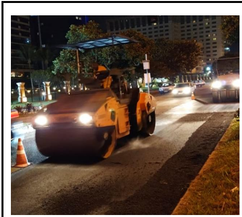
AV. LUCIO COSTA COMPACTAÇÃO (1ª CAMADA)
