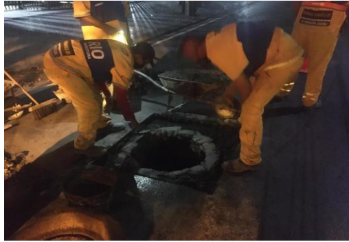
SERVIÇO: LEVANTAMENTO DE TAMPÃO
