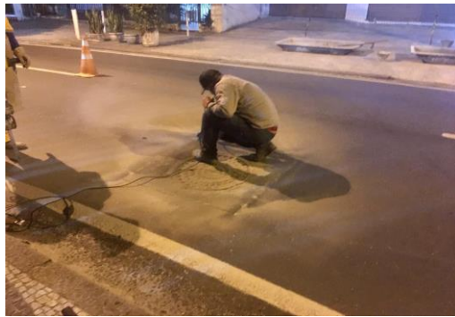
SERVIÇO: LEVANTAMENTO DE TAMPÃO
