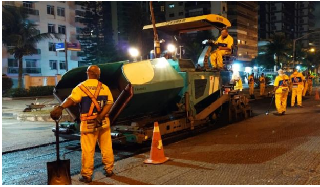
SERVIÇO: REPERFILAGEM DE PAVIMENTO
