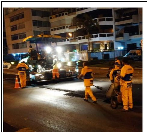
AV. LUCIO COSTA ESPALHAMENTO DE ASFALTO (2ª CAMADA)
