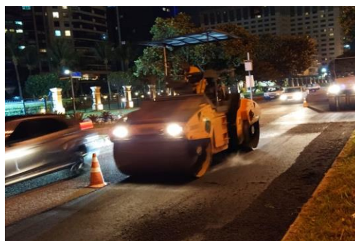
SERVIÇO: COMPACTAÇÃO MECÂNICA
