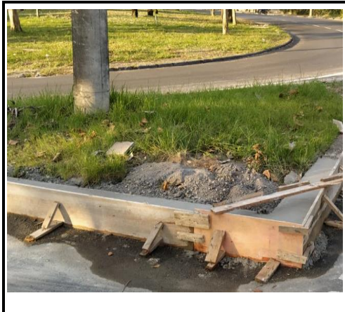
ESTR. DO RIO GRANDE MEIO-FIO DE CONCRETO
