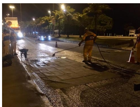
SERVIÇO: APLICAÇÃO DE GEOGRELHA
