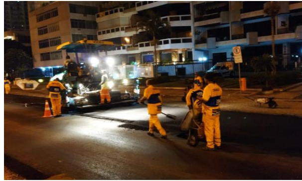
SERVIÇO: ESPALHAMENTO DE CBUQ (2ª CAMADA)
