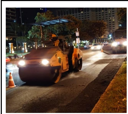
AV. LUCIO COSTA COMPACTAÇÃO (1ª CAMADA)
