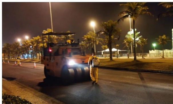
SERVIÇO: COMPACTAÇÃO (2ª CAMADA)
