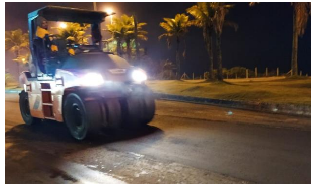
SERVIÇO: REPERFILAGEM DE PAVIMENTO
