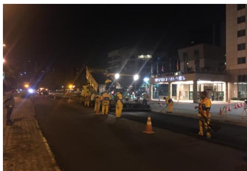
SERVIÇO: ESPALHAMENTO DE ASFALTO
