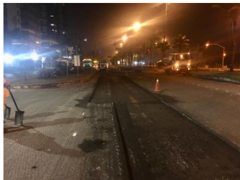
SERVIÇO: REPERFILAGEM DE PAVIMENTO
