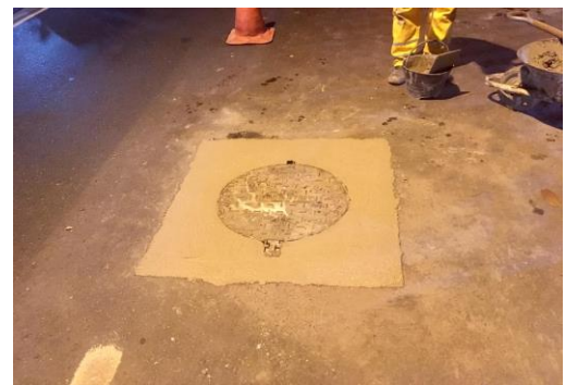
SERVIÇO: LEVANTAMENTO DE TAMPÃO
