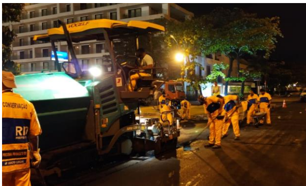
SERVIÇO: ESPALHAMENTO DE CBUQ (2ª CAMADA)
