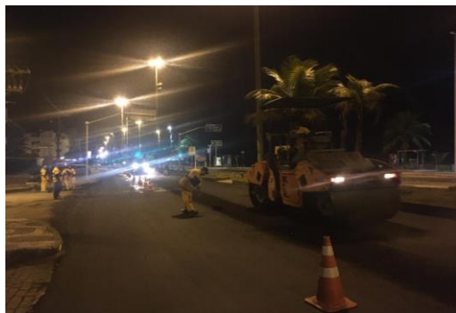
SERVIÇO: COMPACTAÇÃO MECÂNICA
