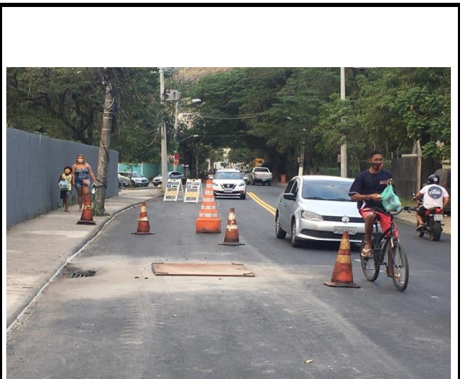
ESTRADA DO RIO GRANDE LEVANTAMENTO DE TAMPÃO
