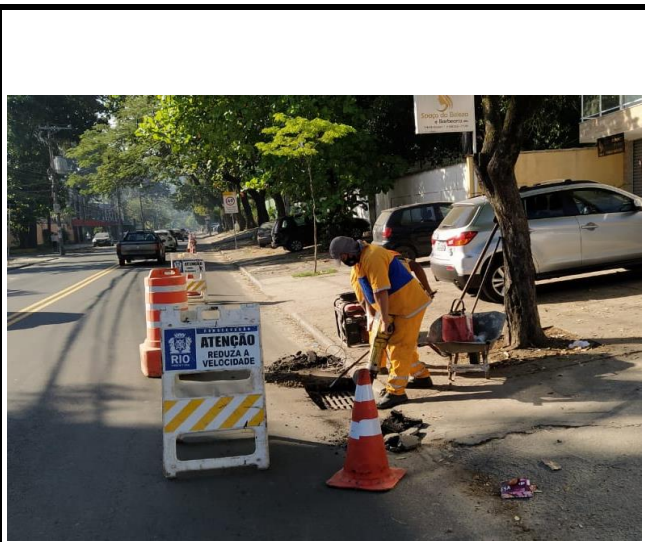
ESTRADA DO RIO GRANDE LEVANTAMENTO DE TAMPÃO
