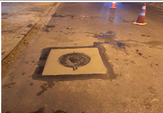
SERVIÇO: LEVANTAMENTO DE TAMPÃO
