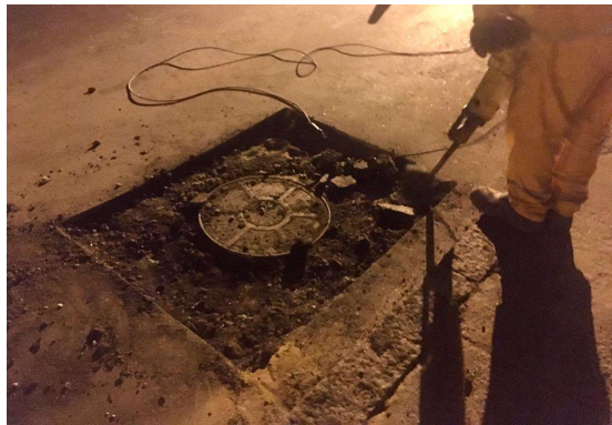
SERVIÇO: LEVANTAMENTO DE TAMPÃO
