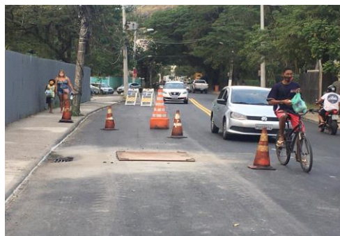
SERVIÇO: LEVANTAMENTO DE TAMPÃO
