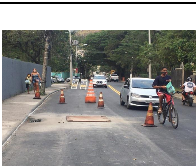
ESTRADA DO RIO GRANDE LEVANTAMENTO DE TAMPÃO
