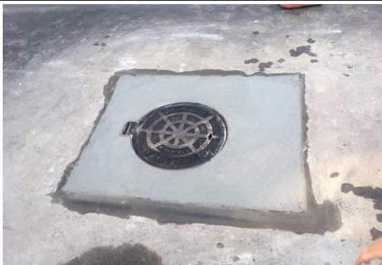
SERVIÇO: LEVANTAMENTO DE TAMPÃO
