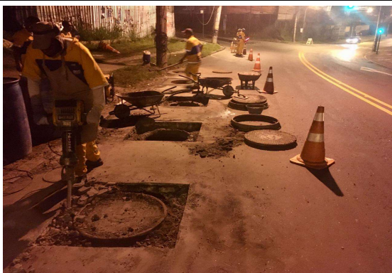
SERVIÇO: LEVANTAMENTO DE TAMPÃO
