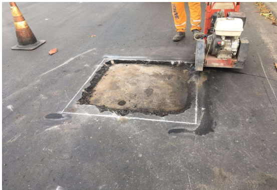
SERVIÇO: LEVANTAMENTO DE TAMPÃO
