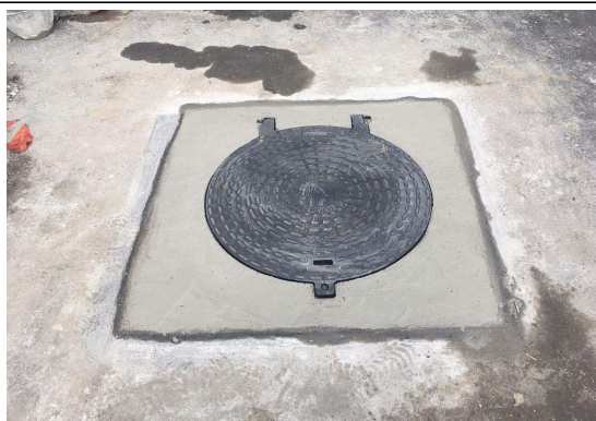
SERVIÇO: LEVANTAMENTO DE TAMPÃO
