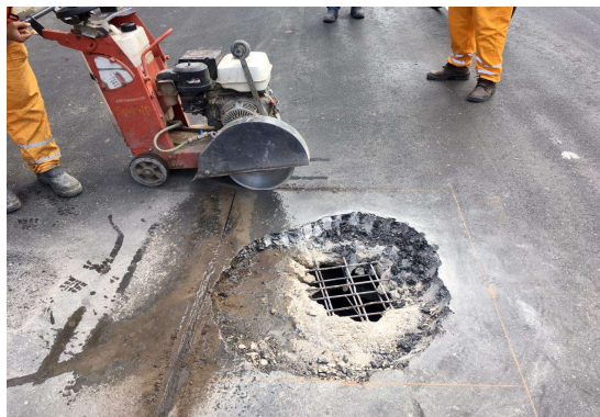
SERVIÇO: LEVANTAMENTO DE TAMPÃO
