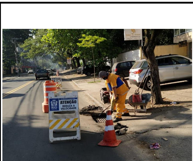
ESTRADA DO RIO GRANDE LEVANTAMENTO DE TAMPÃO
