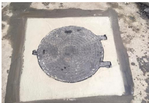
SERVIÇO: LEVANTAMENTO DE TAMPÃO
