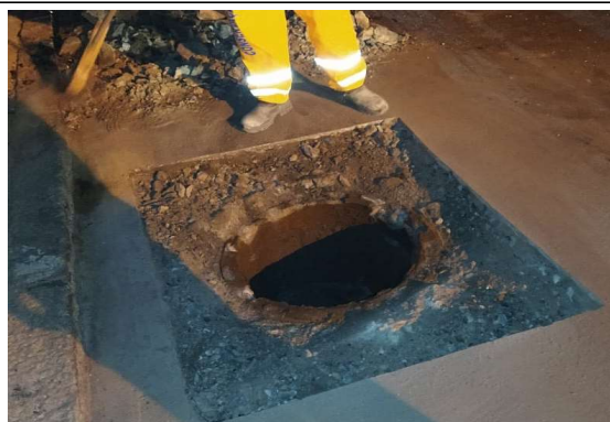
SERVIÇO: LEVANTAMENTO DE TAMPÃO
