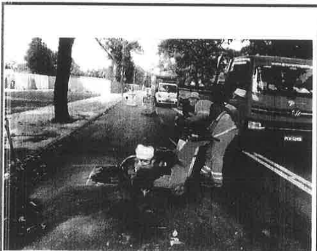
ESTRADA DO RIO GRANDE LEVANTAMENTO DE TAMPÃO
