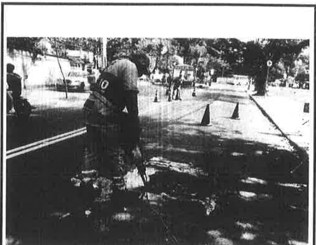
ESTRADA DO RIO GRANDE LEVANTAMENTO DE TAMPÃO
