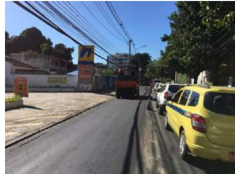
SERVIÇO: COMPACTAÇÃO MECÂNICA
