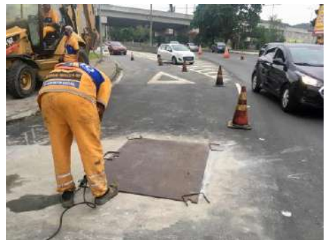
SERVIÇO: LEVANTAMENTO DE TAMPÃO
