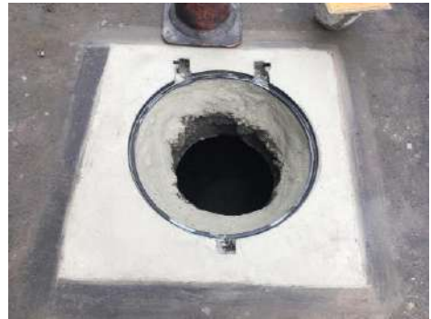
SERVIÇO: LEVANTAMENTO DE TAMPÃO
