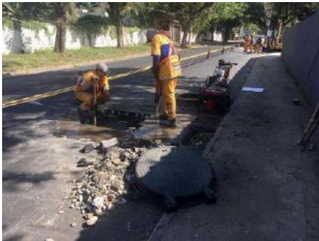
SERVIÇO: LEVANTAMENTO DE TAMPÃO
