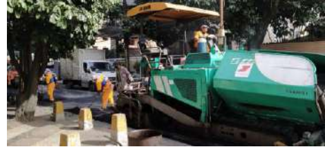
SERVIÇO: ESPALHAMENTO DE ASFALTO
