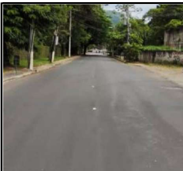
Estrada do Rio Grande Pré-marcação da sinalização horizontal
