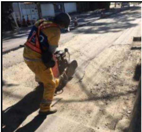
Estrada do Rio Grande Abertura de juntas _ Remendo profundo
