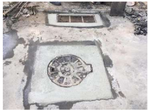
SERVIÇO: LEVANTAMENTO DE TAMPÃO
