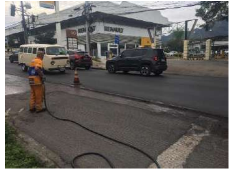
SERVIÇO: PINTURA DE LIGAÇÃO
