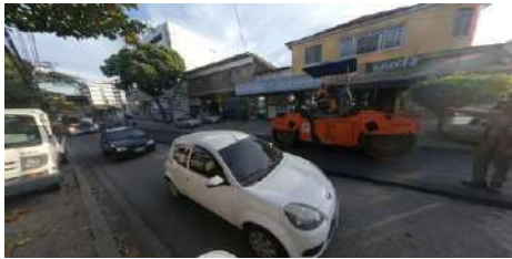
SERVIÇO: COMPACTAÇÃO MECÂNICA
