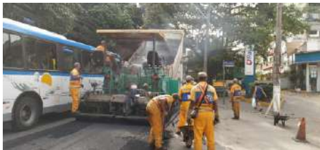
SERVIÇO: ESPALHAMENTO DE ASFALTO
