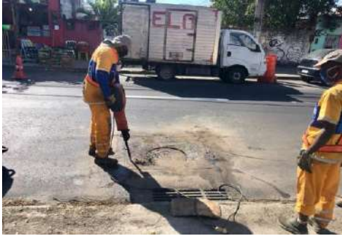
SERVIÇO: LEVANTAMENTO DE TAMPÃO
