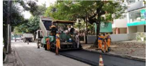
SERVIÇO: ESPALHAMENTO DE ASFALTO
