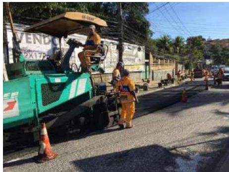
SERVIÇO: ESPALHAMENTO DE ASFALTO
