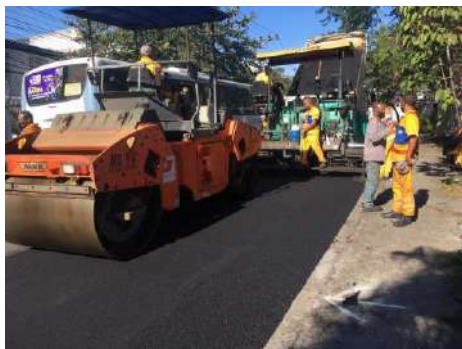
SERVIÇO: COMPACTAÇÃO MECÂNICA
