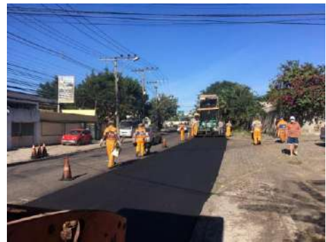
SERVIÇO: ESPALHAMENTO DE ASFALTO
