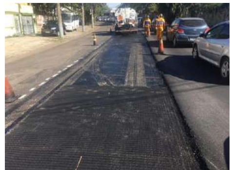
SERVIÇO: APLICAÇÃO DE GEOGRELHA
