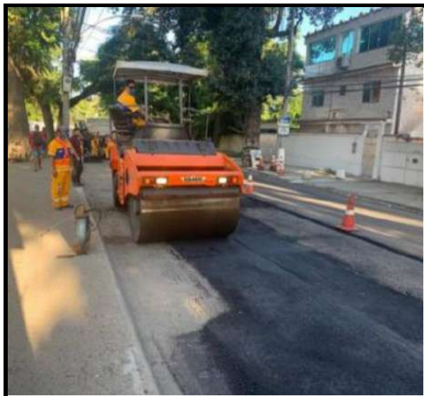
Estrada do Rio Grande Compactação com rolo de chapa _ Remendo profundo
