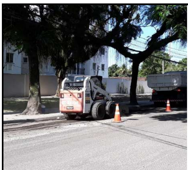
Estrada do Rio Grande Limpeza com minicarregadeira
