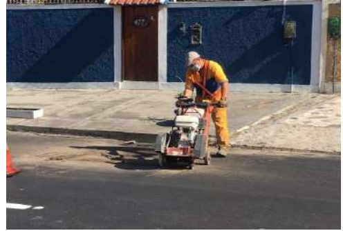
SERVIÇO: LEVANTAMENTO DE TAMPÃO
