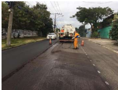
SERVIÇO: PINTURA DE LIGAÇÃO
