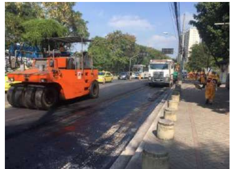
SERVIÇO: COMPACTAÇÃO MECÂNICA
