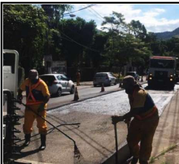
Estrada do Rio Grande Pintura de Ligação
