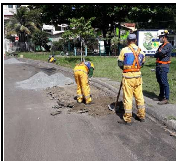
Estrada do Rio Grande Substituição de Base _ Remendo profundo
