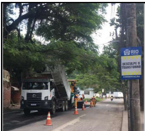
Estrada do Rio Grande Recapeamento com CBUQ
