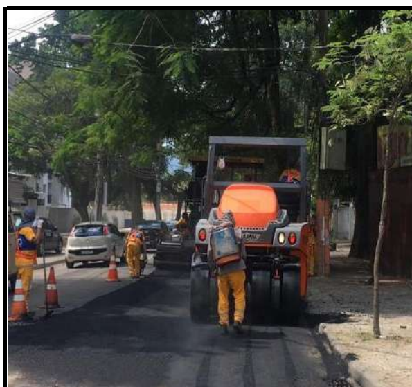
Estrada do Rio Grande Compactação com rolo de pneus
