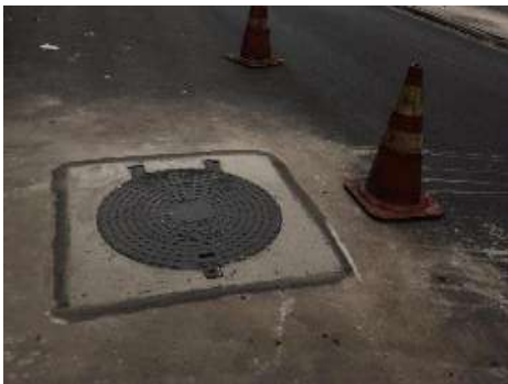
SERVIÇO: LEVANTAMENTO DE TAMPÃO
