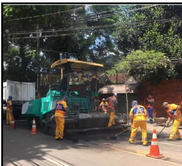
Estrada do Rio Grande Espalhamento de CBUQ com vibro acabadora
