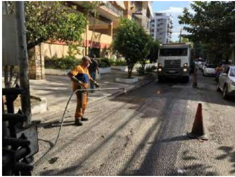
SERVIÇO: PINTURA DE LIGAÇÃO
