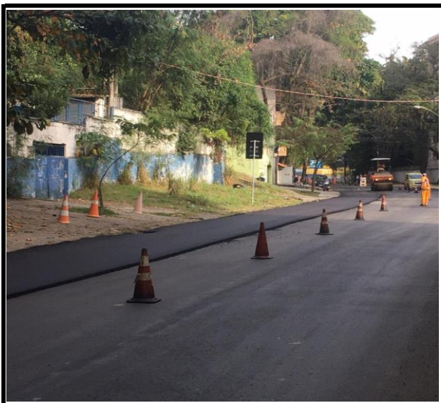
ESTRADA DO RIO GRANDE SINALIZAÇÃO DE OBRAS
