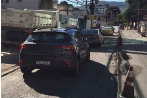
SERVIÇO: SINALIZAÇÃO DE OBRAS
