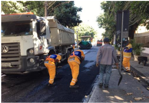
SERVIÇO: ESPALHAMENTO DE ASFALTO
