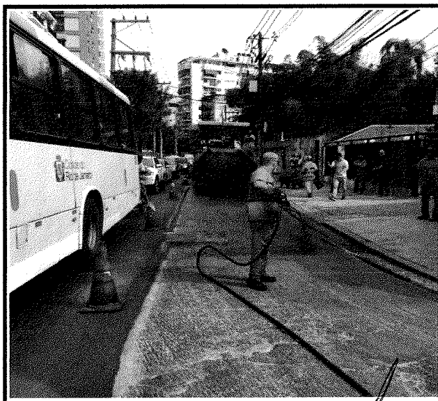
RUA TIROL PINTURA DE LIGAÇÃO
