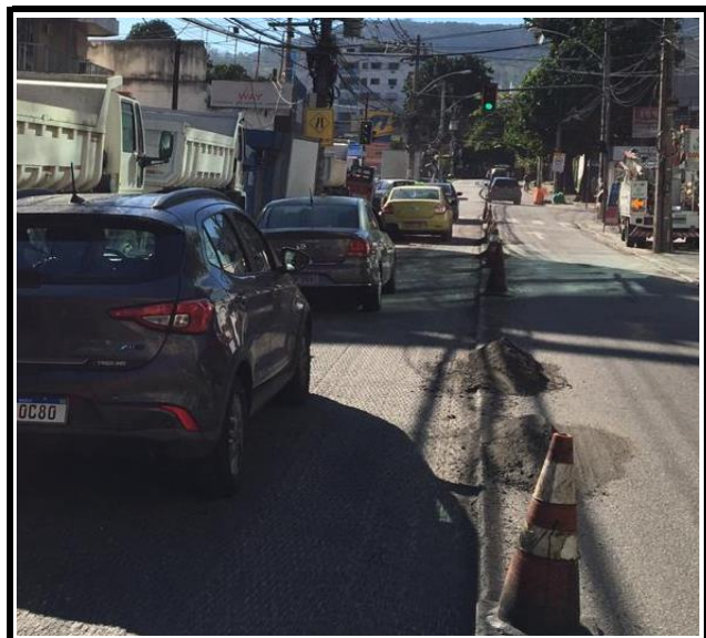
RUA CMT RUBENS SILVA SINALIZAÇÃO DE OBRAS
