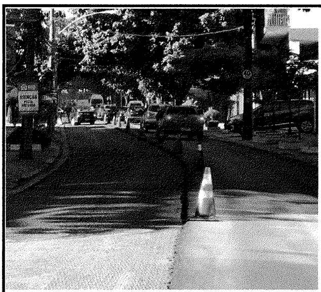
RUA TIROL SINALIZAÇÃO DE OBRAS
