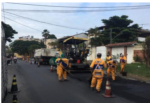
SERVIÇO: ESPALHAMENTO DE ASFALTO
