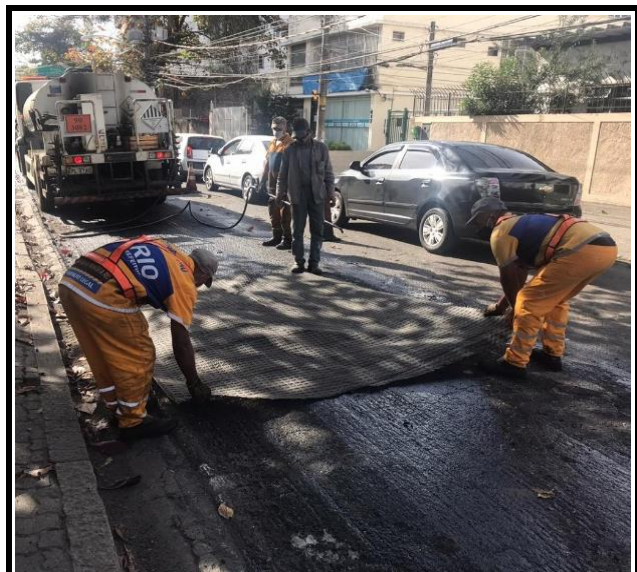
RUA TIROL APLICAÇÃO DE GEOGRELHA
