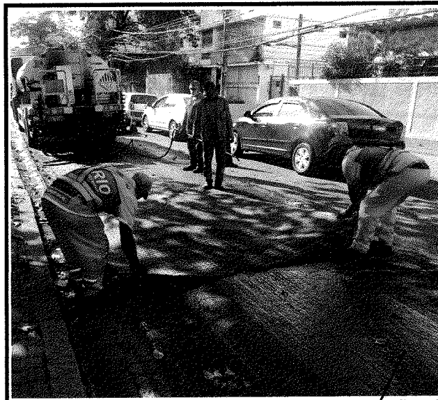
RUA TIROL APLICAÇÃO DE GEOGRELHA
