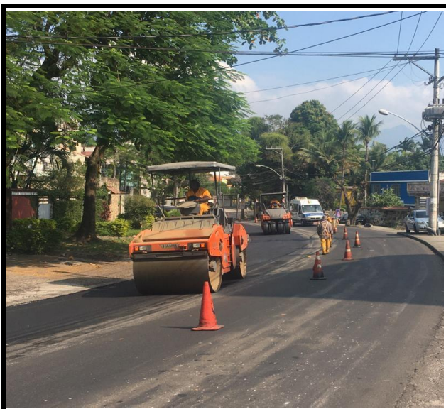
ESTRADA DO RIO GRANDE COMPACTAÇÃO MECÂNICA
