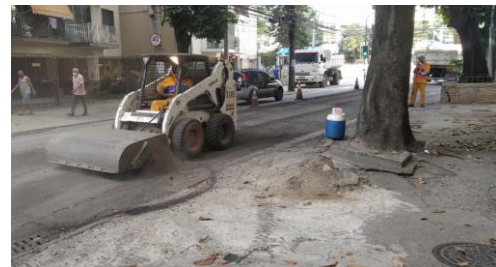
SERVIÇO: EQUIPE DE APOIO (LIMPEZA DA PISTA)
