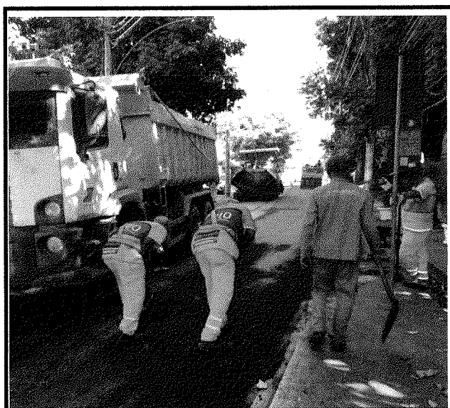
RUA TIROL ESPALHAMENTO DE ASFALTO
