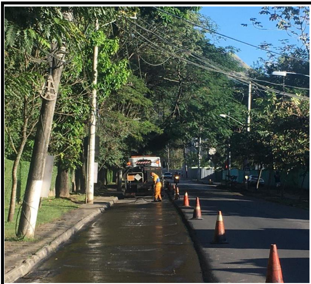
ESTRADA DO RIO GRANDE PINTURA DE LIGAÇÃO
