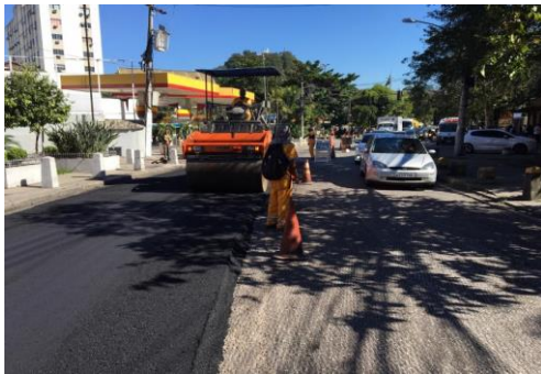
SERVIÇO: COMPACTAÇÃO MECÂNICA
