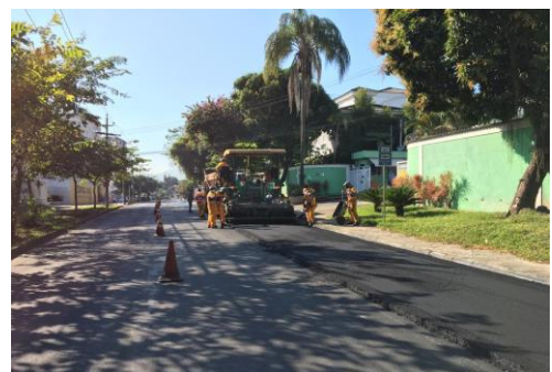
SERVIÇO: ESPALHAMENTO DE ASFALTO
