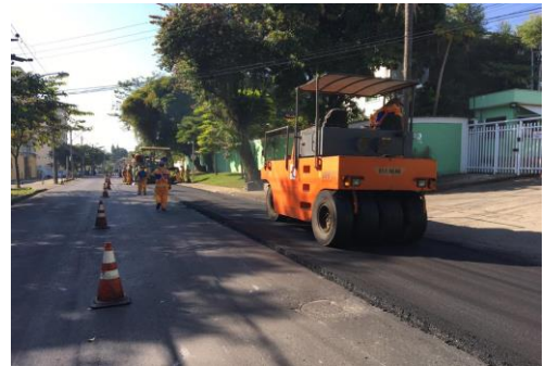
SERVIÇO: COMPACTAÇÃO MECÂNICA
