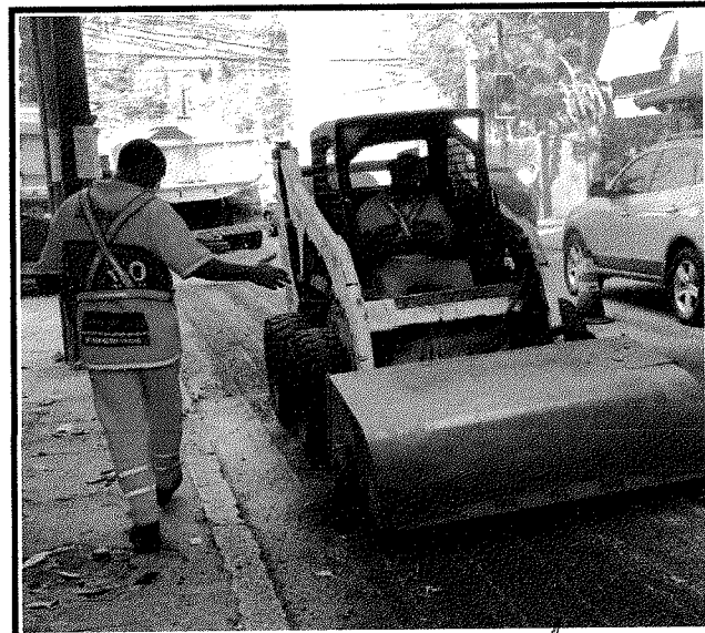
RUA CMT RUBENS SILVA EQUIPE DE APOIO (LIMPEZA DE PISTA)
