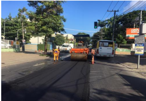
SERVIÇO: COMPACTAÇÃO MECÂNICA
