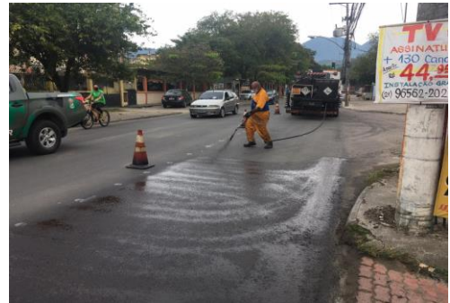
SERVIÇO: PINTURA DE LIGAÇÃO
