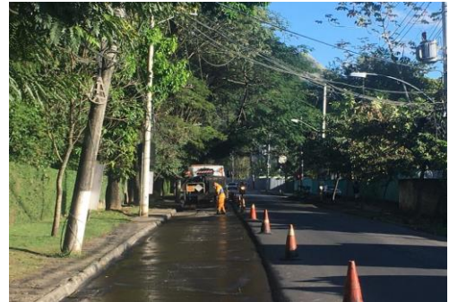
SERVIÇO: PINTURA DE LIGAÇÃO
