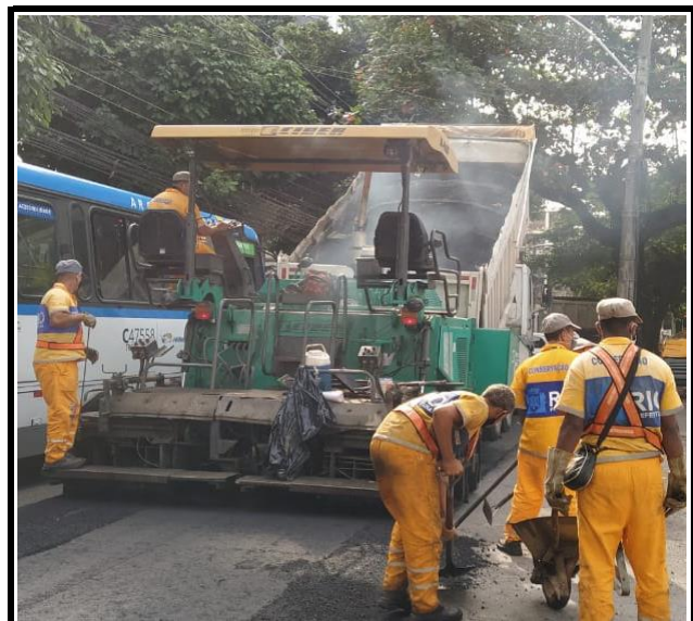
RUA CMT RUBENS SILVA ESPALHAMENTO DE ASFALTO
