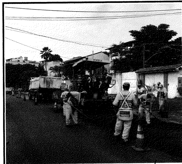
ESTRADA DO RIO GRANDE ESPALHAMENTO DE ASFALTO
