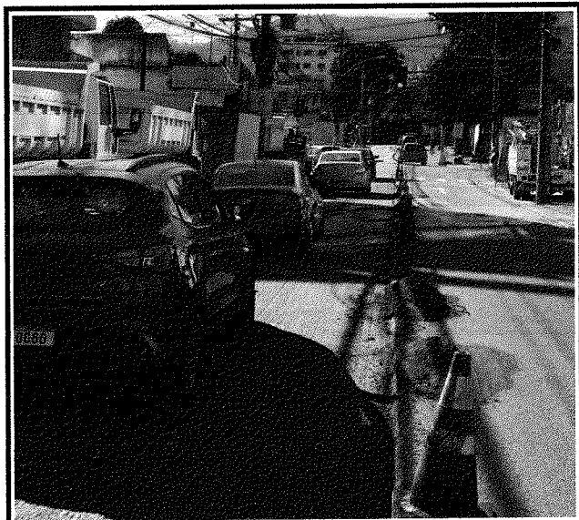
RUA CMT RUBENS SILVA SINALIZAÇÃO DE OBRAS
