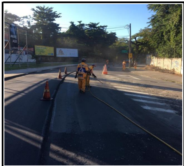
ESTRADA DO RIO GRANDE EQUIPE DE APOIO (LIMPEZA DE PISTA)
