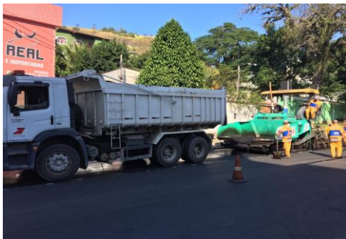
SERVIÇO: ESPALHAMENTO DE ASFALTO
