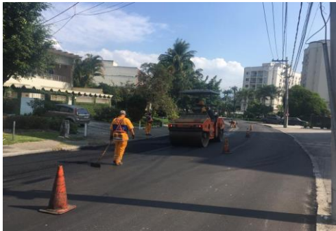
SERVIÇO: COMPACTAÇÃO MECÂNICA
