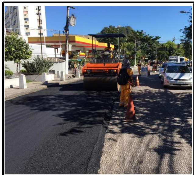
RUA TIROL COMPACTAÇÃO MECÂNICA
