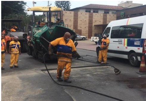
SERVIÇO: PINTURA DE LIGAÇÃO
