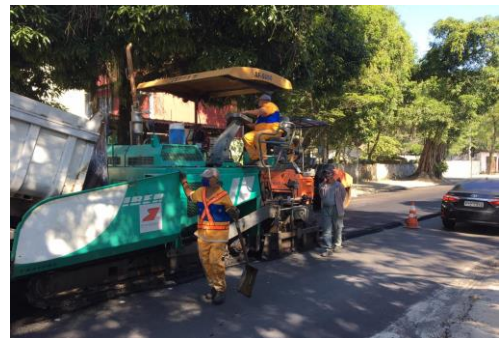
SERVIÇO: ESPALHAMENTO DE ASFALTO
