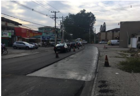
SERVIÇO: PINTURA DE LIGAÇÃO
