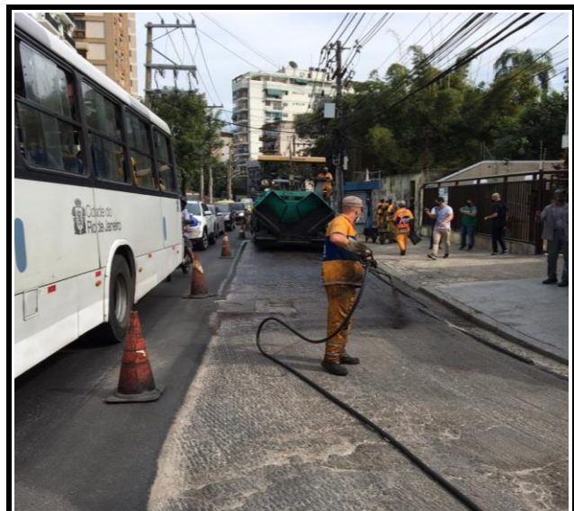
RUA TIROL PINTURA DE LIGAÇÃO
