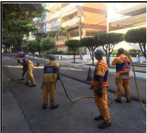
RUA TIROL EQUIPE DE APOIO (LIMPEZA DE PISTA)
