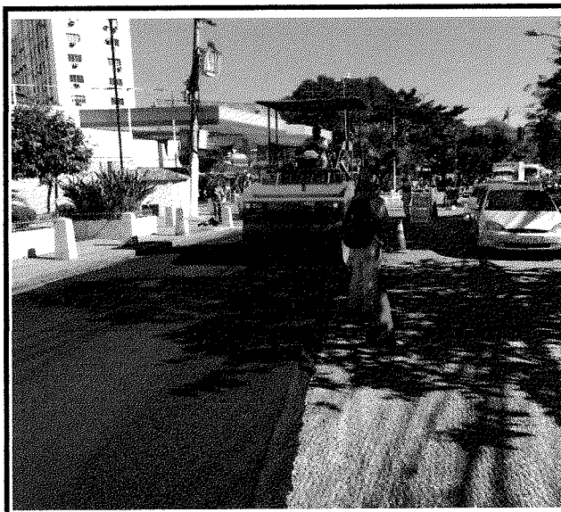
RUA TIROL COMPACTAÇÃO MECÂNICA
