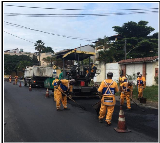
ESTRADA DO RIO GRANDE ESPALHAMENTO DE ASFALTO
