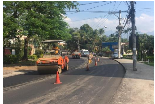
SERVIÇO: COMPACTAÇÃO MECÂNICA
