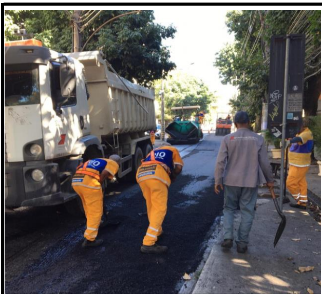
RUA TIROL ESPALHAMENTO DE ASFALTO
