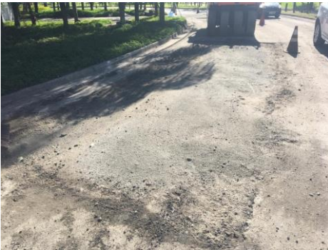
SERVIÇO: REMENDO PROFUNDO
