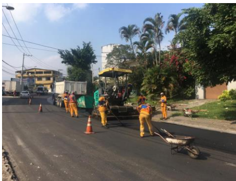
SERVIÇO: ESPALHAMENTO DE ASFALTO
