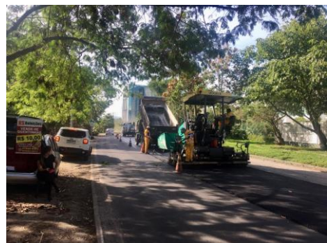
SERVIÇO: ESPALHAMENTO DE ASFALTO
