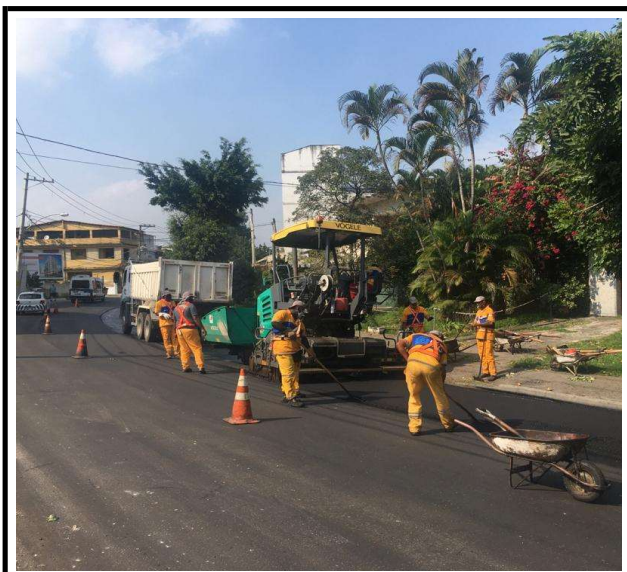
ESTRADA DO RIO GRANDE ESPALHAMENTO DE ASFALTO
