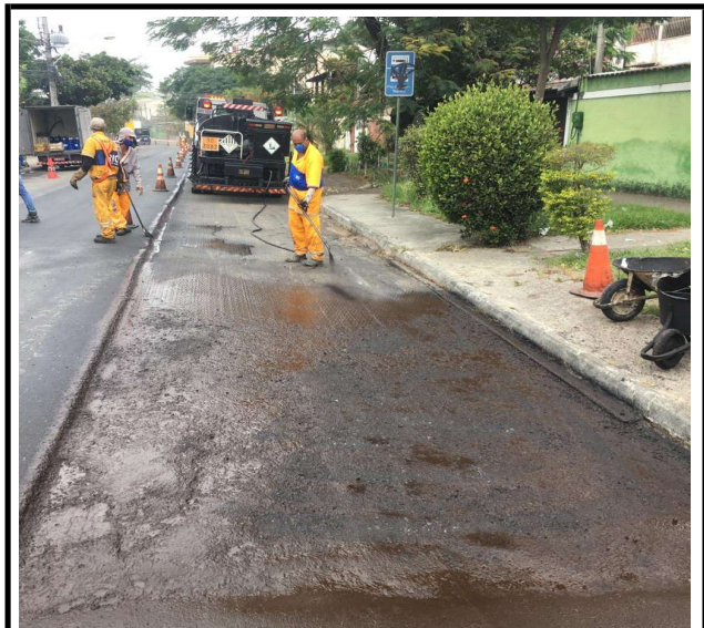
ESTRADA DO RIO GRANDE PINTURA DE LIGAÇÃO
