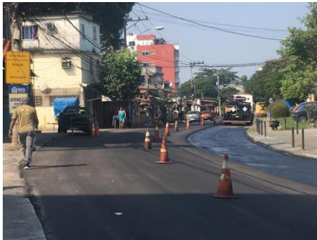
SERVIÇO: PINTURA DE LIGAÇÃO
