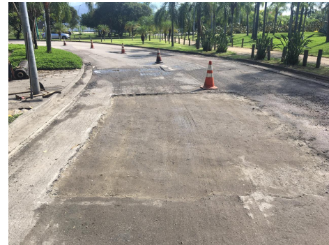
SERVIÇO: REMENDO PROFUNDO
