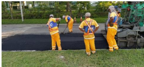
SERVIÇO: ESPALHAMENTO DE ASFALTO
