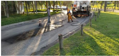
SERVIÇO: PINTURA DE LIGAÇÃO
