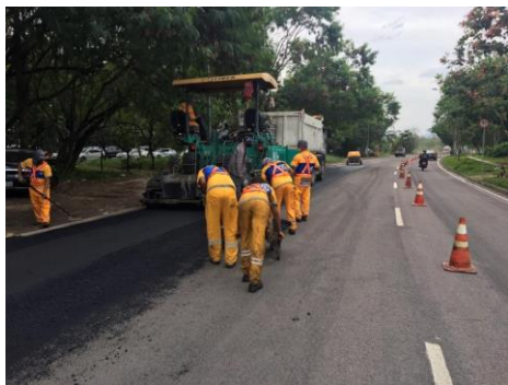
SERVIÇO: ESPALHAMENTO DE ASFALTO
