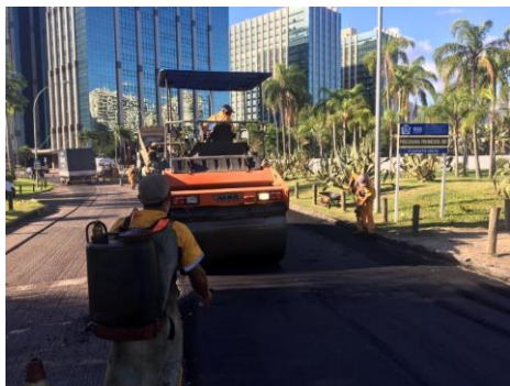
SERVIÇO: COMPACTAÇÃO MECÂNICA
