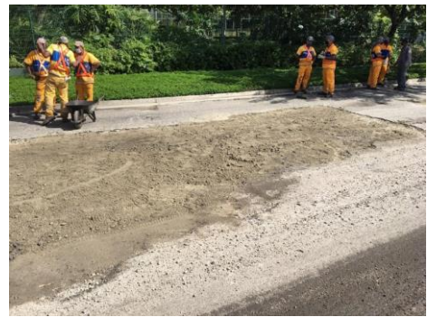
SERVIÇO: REMENDO PROFUNDO
