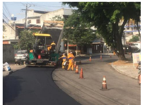
SERVIÇO: ESPALHAMENTO DE ASFALTO
