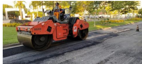
SERVIÇO: COMPACTAÇÃO MECÂNICA
