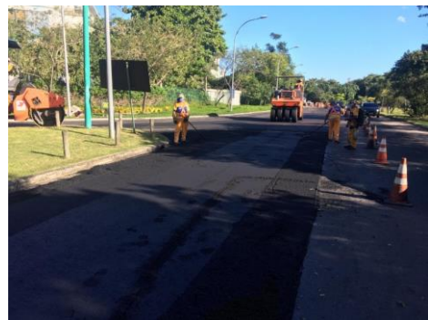
SERVIÇO: COMPACTAÇÃO MECÂNICA
