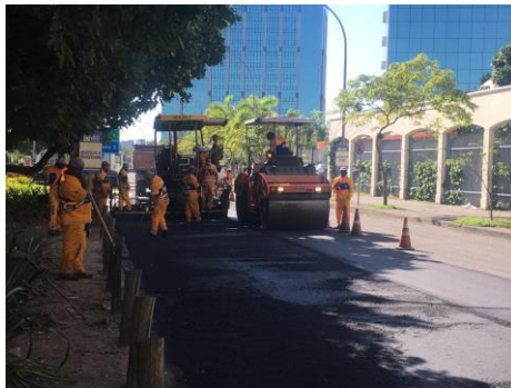
SERVIÇO: COMPACTAÇÃO MECÂNICA
