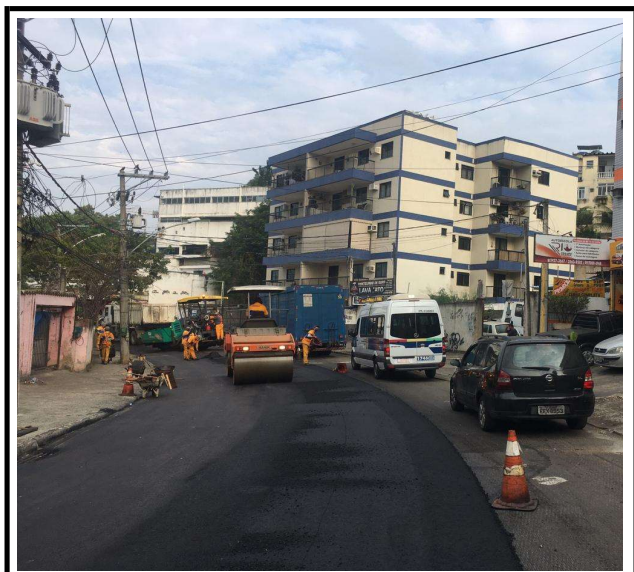
ESTRADA DO RIO GRANDE COMPACTAÇÃO MECÂNICA
