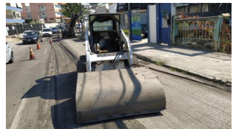
SERVIÇO: EQUIPE DE APOIO (LIMPEZA DA PISTA)
