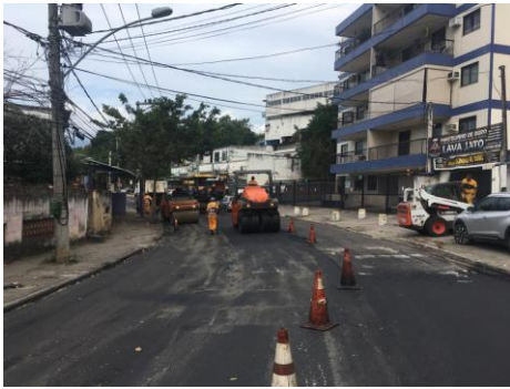
SERVIÇO: COMPACTAÇÃO MECÂNICA
