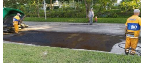
SERVIÇO: PINTURA DE LIGAÇÃO
