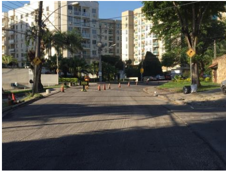
SERVIÇO: SINALIZAÇÃO DE OBRAS
