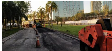
SERVIÇO: ESPALHAMENTO DE ASFALTO
