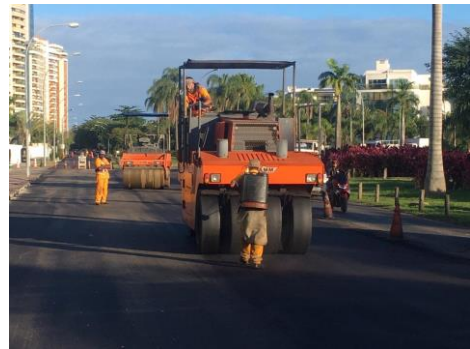
SERVIÇO: COMPACTAÇÃO MECÂNICA
