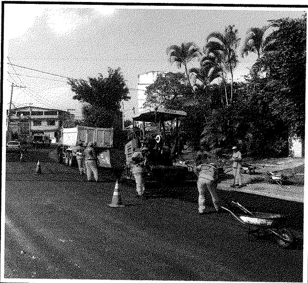
ESTRADA DO RIO GRANDE ESPALHAMENTO DE ASFALTO
