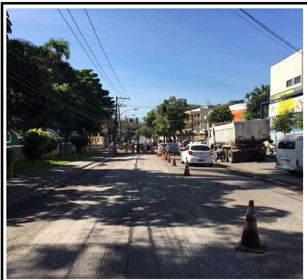
ESTRADA DO RIO GRANDE SINALIZAÇÃO DE OBRAS
