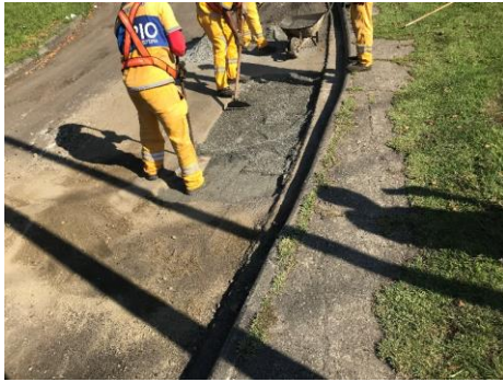
SERVIÇO: REMENDO PROFUNDO
