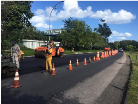
SERVIÇO: COMPACTAÇÃO MECÂNICA
