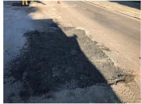
SERVIÇO: REMENDO PROFUNDO
