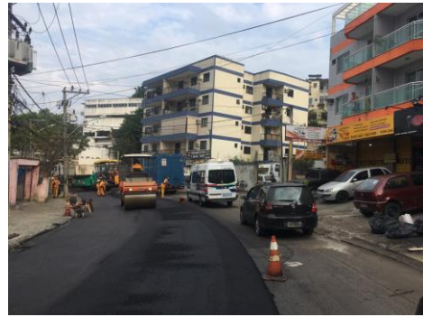
SERVIÇO: COMPACTAÇÃO MECÂNICA
