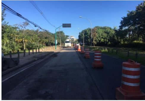
SERVIÇO: SINALIZAÇÃO DE OBRAS
