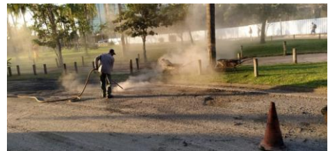
SERVIÇO: EQUIPE DE APOIO (LIMPEZA DA PISTA)
