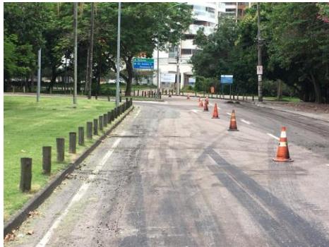
SERVIÇO: SINALIZAÇÃO DE OBRAS
