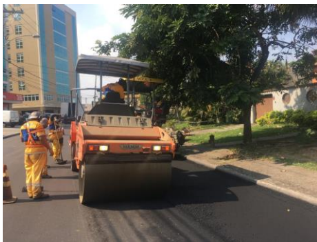
SERVIÇO: COMPACTAÇÃO MECÂNICA
