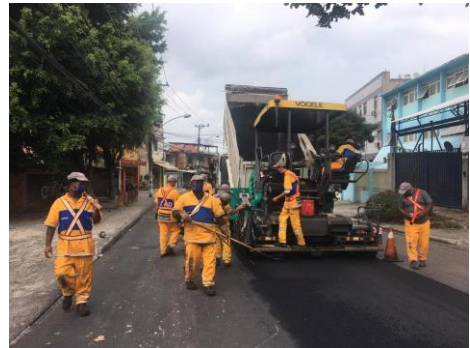
SERVIÇO: ESPALHAMENTO DE ASFALTO
