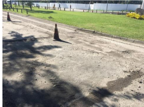
SERVIÇO: REMENDO PROFUNDO
