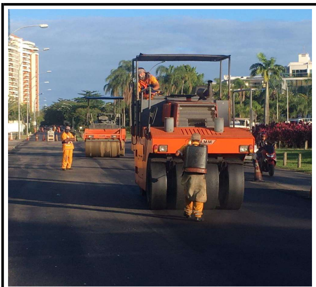
AV. JOÃO CABRAL DE MELLO NETO COMPACTAÇÃO MECÂNICA
