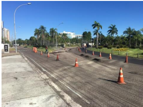
SERVIÇO: SINALIZAÇÃO DE OBRAS
