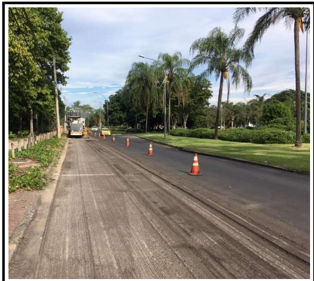
AV. JOÃO CABRAL DE MELLO NETO SINALIZAÇÃO DE OBRAS
