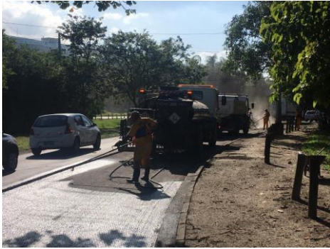
SERVIÇO: PINTURA DE LIGAÇÃO
