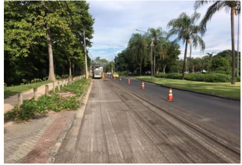
SERVIÇO: SINALIZAÇÃO DE OBRAS
