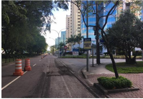
SERVIÇO: SINALIZAÇÃO DE OBRAS
