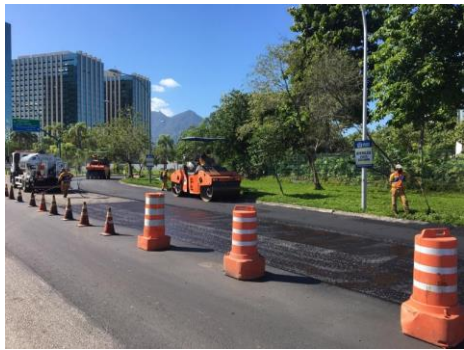
SERVIÇO: PINTURA DE LIGAÇÃO
