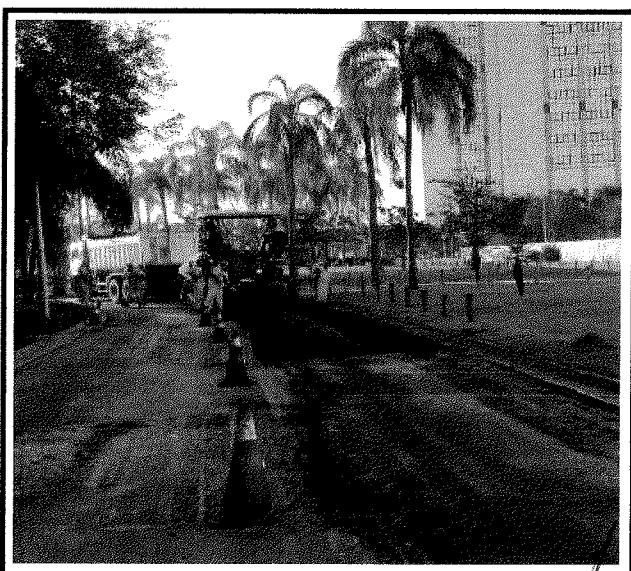
AV. JOÃO CABRAL DE MELLO NETO ESPALHAMENTO DE ASFALTO
