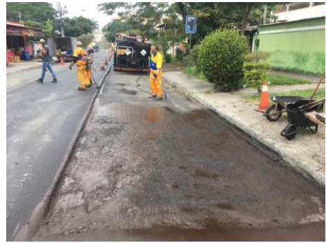
SERVIÇO: PINTURA DE LIGAÇÃO
