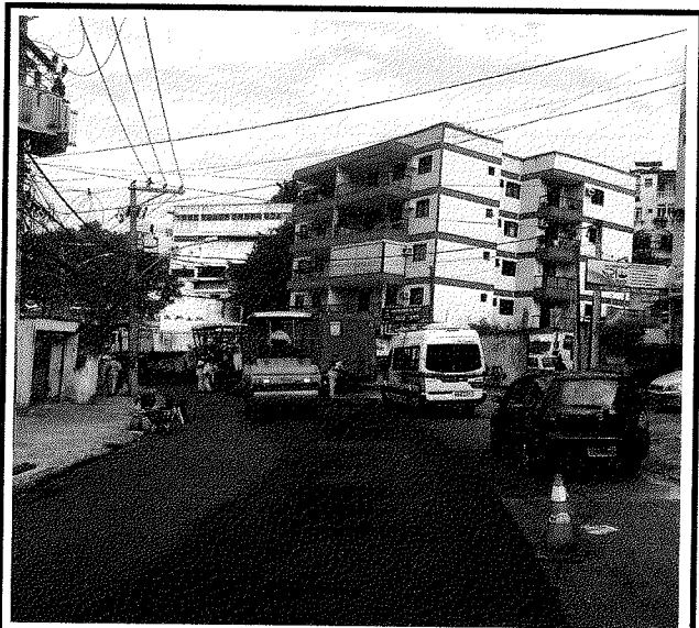
ESTRADA DO RIO GRANDE COMPACTAÇÃO MECÂNICA
