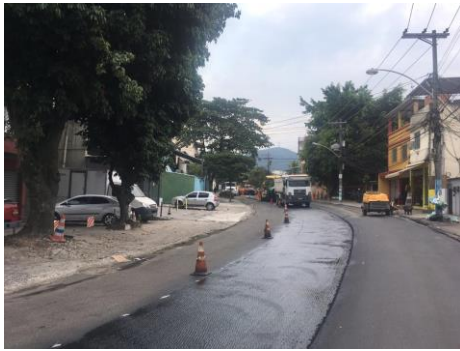
SERVIÇO: PINTURA DE LIGAÇÃO
