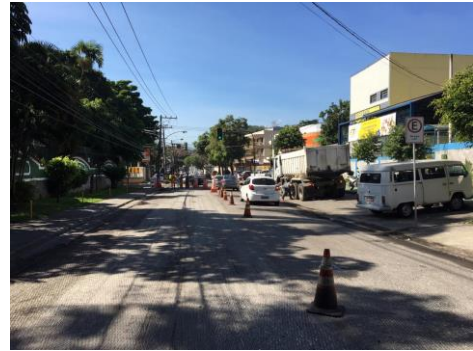
SERVIÇO: SINALIZAÇÃO DE OBRAS
