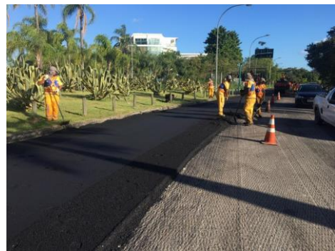
SERVIÇO: ESPALHAMENTO DE ASFALTO
