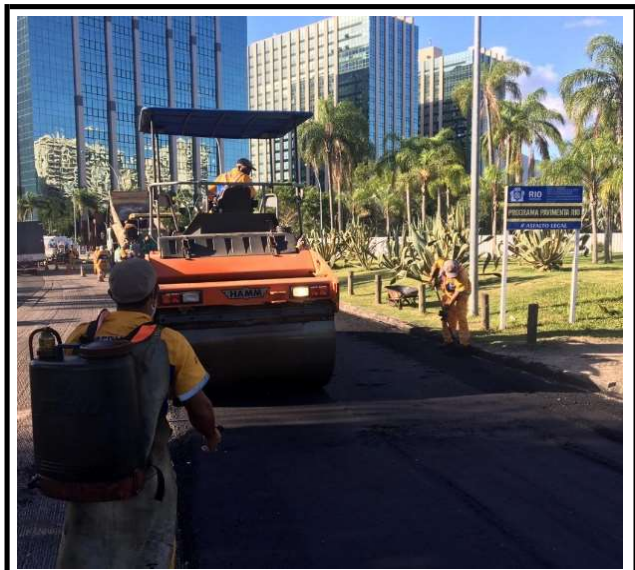
AV. JOSÉ SILVA DE AZEVEDO NETO COMPACTAÇÃO MECÂNICA
