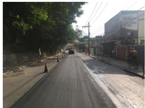
SERVIÇO: COMPACTAÇÃO MECÂNICA
