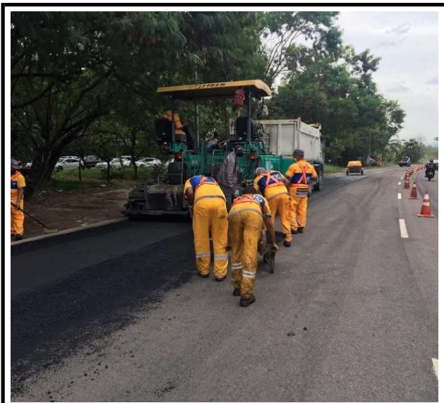
AV. JOSÉ SILVA DE AZEVEDO NETO ESPALHAMENTO DE ASFALTO
