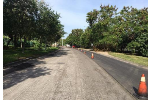
SERVIÇO: SINALIZAÇÃO DE OBRAS
