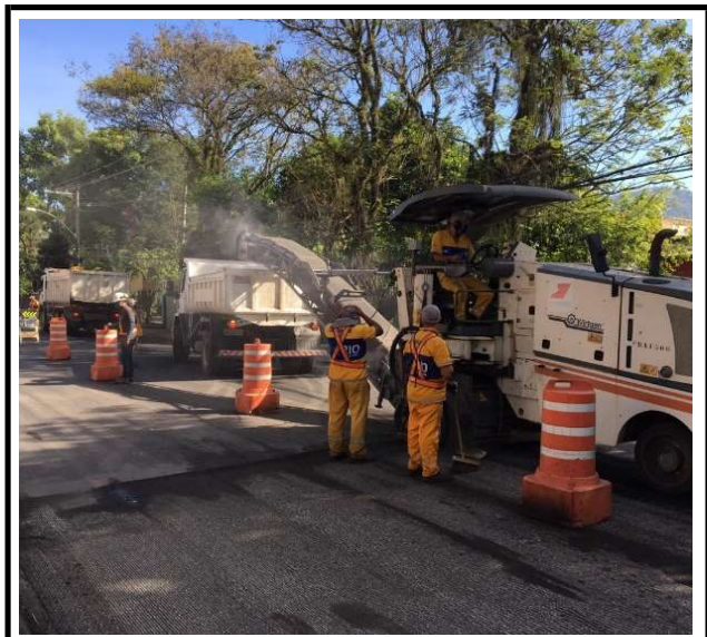
ESTRADA DO RIO GRANDE FRESAGEM
