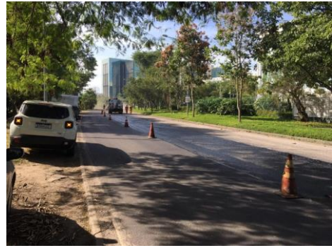
SERVIÇO: PINTURA DE LIGAÇÃO
