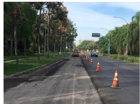
SERVIÇO: EQUIPE DE APOIO (LIMPEZA DA PISTA)
