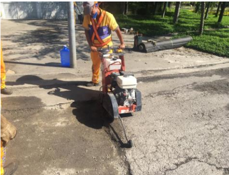
SERVIÇO: REMENDO PROFUNDO
