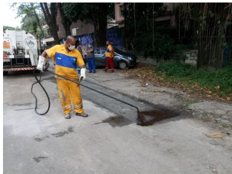
SERVIÇO: REMENDO PROFUNDO
