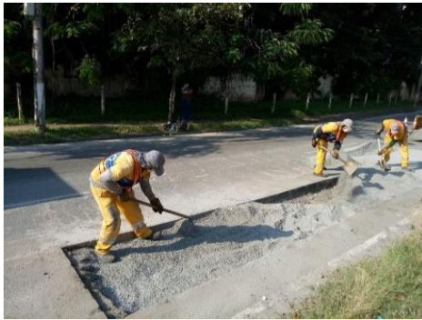
SERVIÇO: REMENDO PROFUNDO
