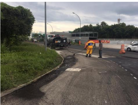
SERVIÇO: PINTURA DE LIGAÇÃO
