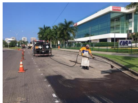
SERVIÇO: PINTURA DE LIGAÇÃO
