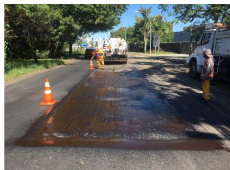
SERVIÇO: PINTURA DE LIGAÇÃO
