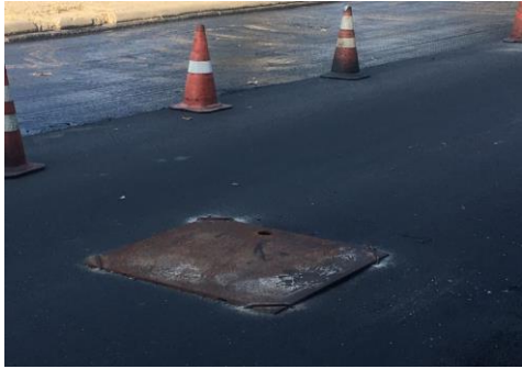
SERVIÇO: CHAPA DE AÇO
