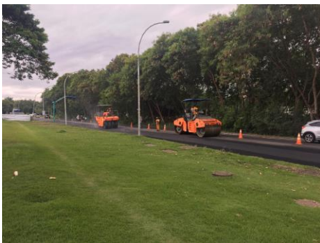
SERVIÇO: COMPACTAÇÃO MECÂNICA
