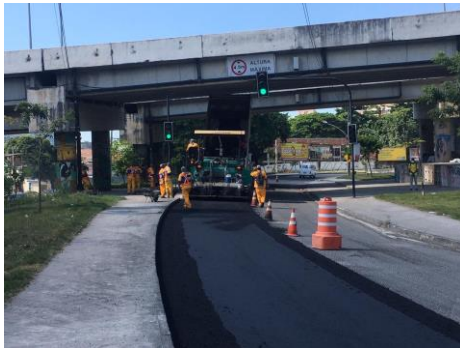
SERVIÇO: ESPALHAMENTO DE ASFALTO
