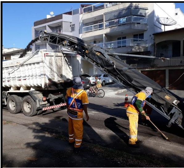
Estrada do Rio Grande Corte mecânico com fresadora
