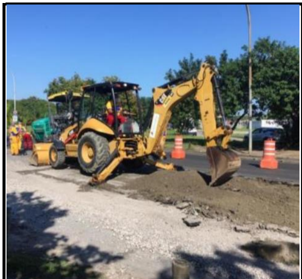
Av. Paisagista José Silva de Azevedo Neto Escavação mecânica _ Remendo profundo
