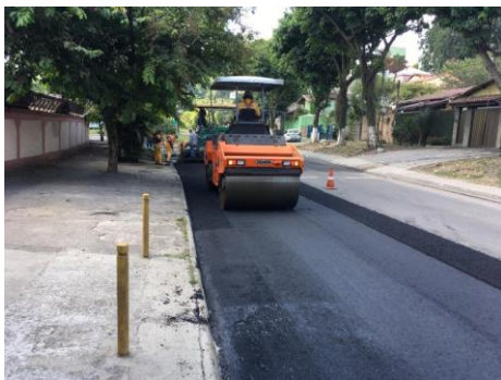
SERVIÇO: COMPACTAÇÃO MECÂNICA
