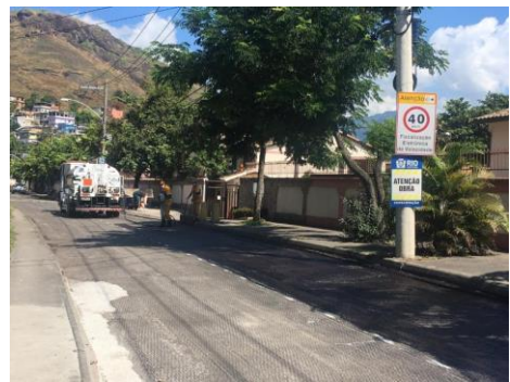
SERVIÇO: PINTURA DE LIGAÇÃO
