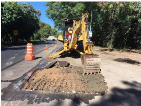
SERVIÇO: REMENDO PROFUNDO
