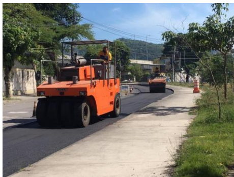
SERVIÇO: COMPACTAÇÃO MECÂNICA
