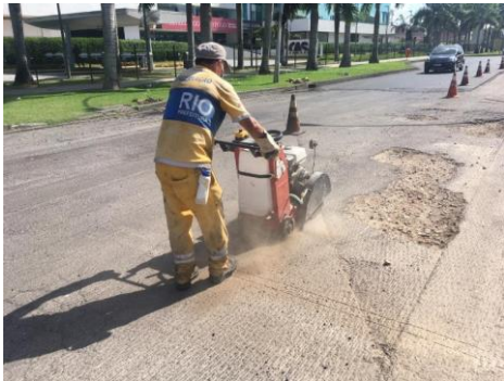
SERVIÇO: REMENDO PROFUNDO
