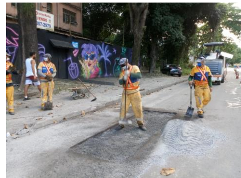
SERVIÇO: REMENDO PROFUNDO
