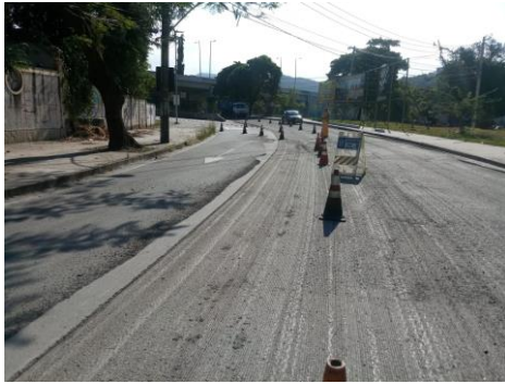
SERVIÇO: SINALIZAÇÃO DE OBRAS
