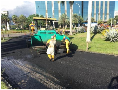
SERVIÇO: ESPALHAMENTO DE ASFALTO
