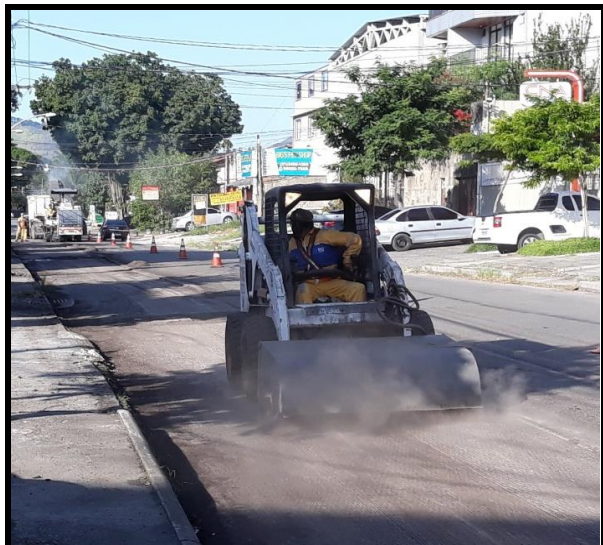
Estrada do Rio Grande Limpeza com minicarregadeira
