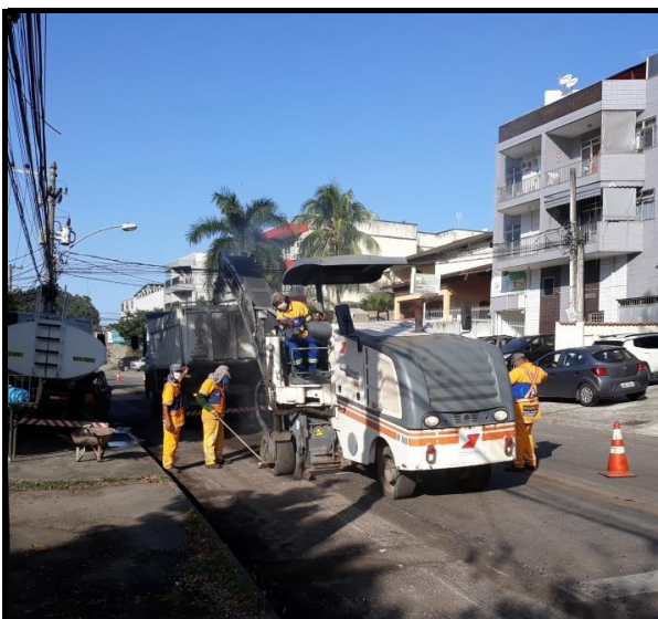
Estrada do Rio Grande Corte mecânico com fresadora
