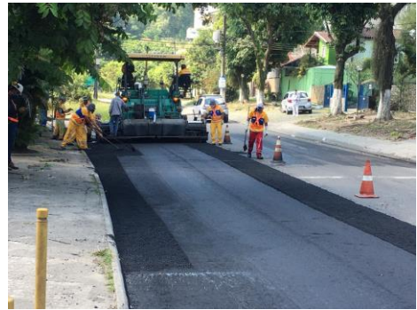
SERVIÇO: ESPALHAMENTO DE ASFALTO
