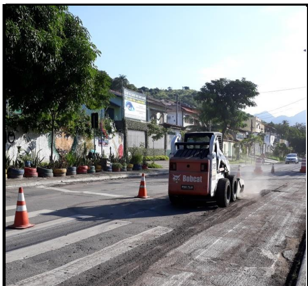
Estrada do Rio Grande Limpeza com minicarregadeira
