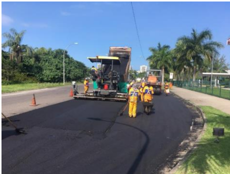
SERVIÇO: ESPALHAMENTO DE ASFALTO
