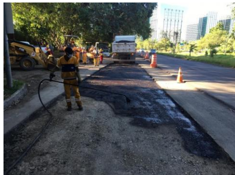
SERVIÇO: REMENDO PROFUNDO
