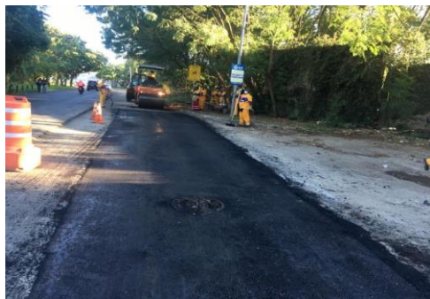
SERVIÇO: REMENDO PROFUNDO
