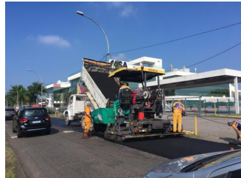
SERVIÇO: ESPALHAMENTO DE ASFALTO
