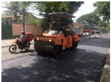
SERVIÇO: COMPACTAÇÃO MECÂNICA
