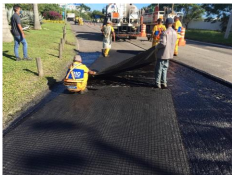
SERVIÇO: REMENDO PROFUNDO
