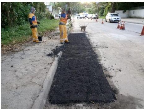
SERVIÇO: REMENDO PROFUNDO
