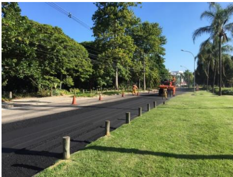
SERVIÇO: COMPACTAÇÃO MECÂNICA
