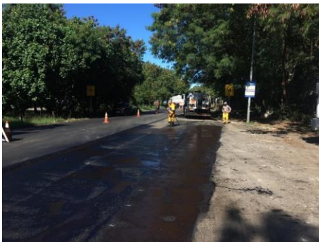
SERVIÇO: PINTURA DE LIGAÇÃO
