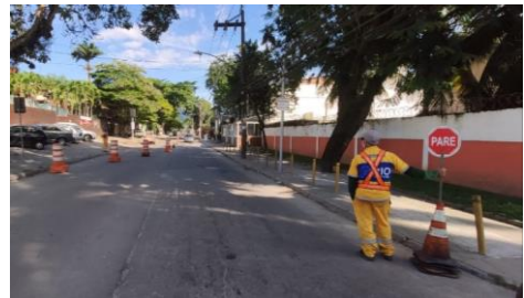
SERVIÇO: SINALIZAÇÃO DE OBRAS
