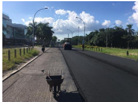
SERVIÇO: COMPACTAÇÃO MECÂNICA
