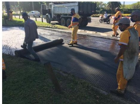
SERVIÇO: REMENDO PROFUNDO
