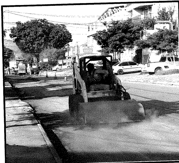
Estrada do Rio Grande Limpeza com minicarregadeira
