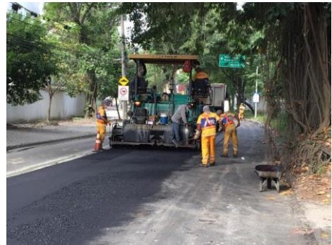
SERVIÇO: ESPALHAMENTO DE ASFALTO
