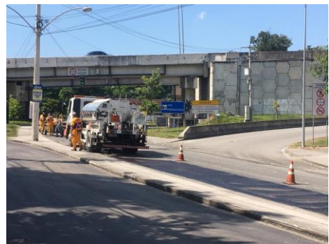
SERVIÇO: PINTURA DE LIGAÇÃO
