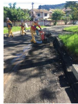
SERVIÇO: REMENDO PROFUNDO
