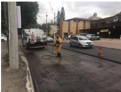
SERVIÇO: PINTURA DE LIGAÇÃO
