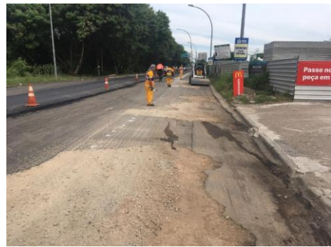
SERVIÇO: REMENDO PROFUNDO
