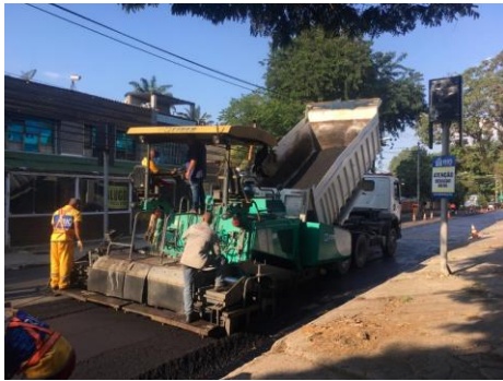
SERVIÇO: ESPALHAMENTO DE ASFALTO
