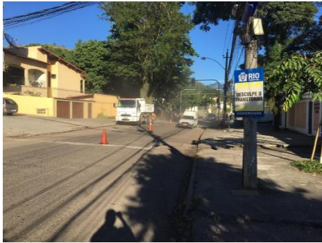
SERVIÇO: SINALIZAÇÃO DE OBRAS
