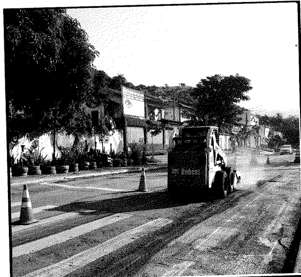
Estrada do Rio Grande Limpeza com minicarregadeira
