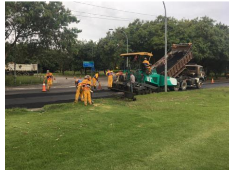
SERVIÇO: ESPALHAMENTO DE ASFALTO
