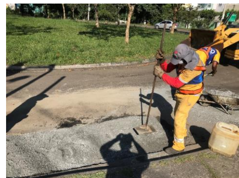
SERVIÇO: REMENDO PROFUNDO
