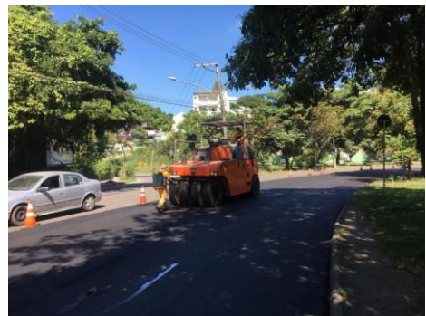
SERVIÇO: COMPACTAÇÃO MECÂNICA
