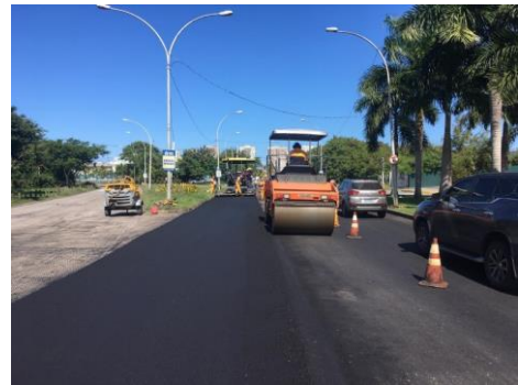
SERVIÇO: COMPACTAÇÃO MECÂNICA
