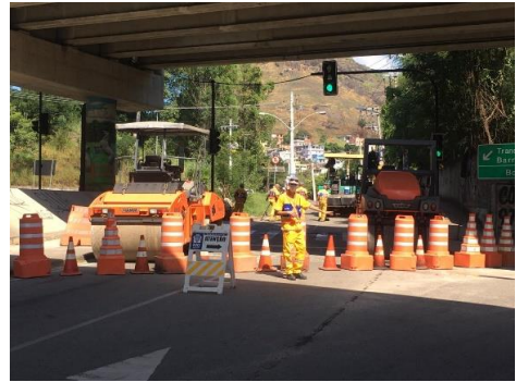
SERVIÇO: SINALIZAÇÃO DE OBRAS
