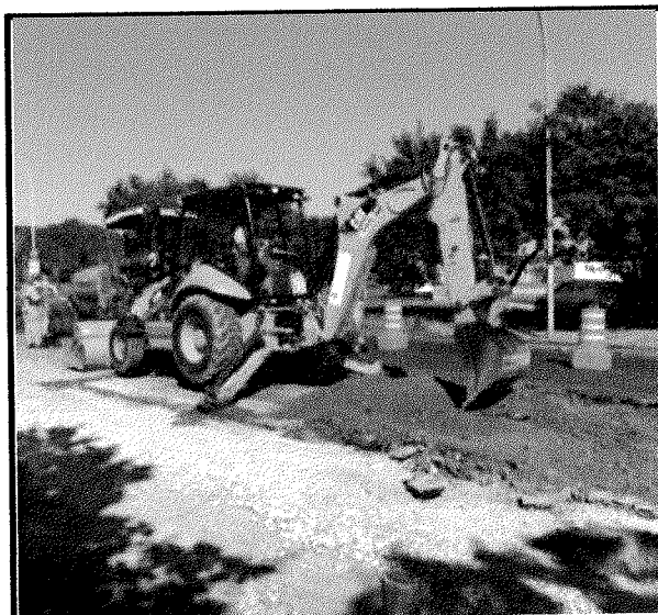
Av. Paisagista José Silva de Azevedo Neto Escavação mecânica _ Remendo profundo
