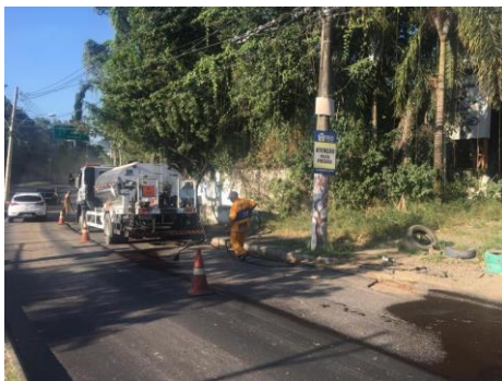
SERVIÇO: PINTURA DE LIGAÇÃO
