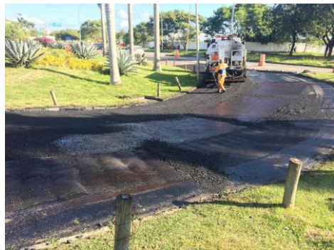
SERVIÇO: REMENDO PROFUNDO
